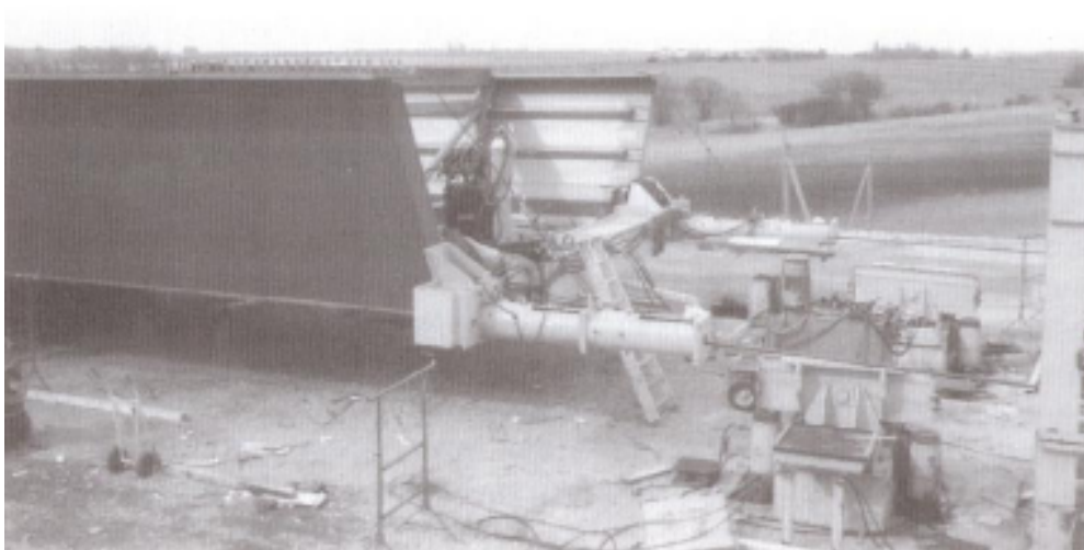
Slika 1: Potisni sistem z dvojnimi batmi pri narivanju jeklenega U nosilca (Rosignoli, 2002, str. 34)
