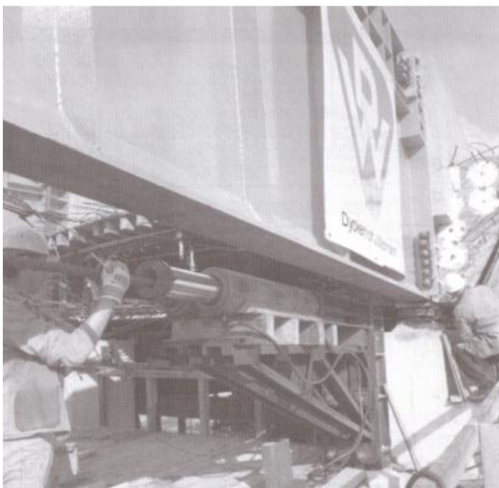
Slika 2: Potisni sistem zasidran v opornik (Rosignoli, 2002, str. 35)
