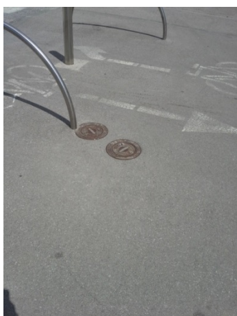
Slika 10: Dvosmerna kolesarska steza, lokacija: Koseška cesta
