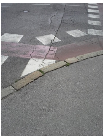
Slika 12: Vključevanje kolesarske steze na kolesarski pas, lokacija: Trg Mladinskih delovnih brigad
