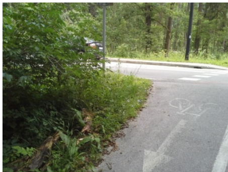
Slika 17: Slaba preglednost pri prečkanju kolesarske poti čez glavno cesto, lokacija: Večna Pot
