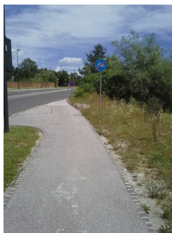
Slika 19: Vključevanje kolesarske steze na cesto, lokacija: Podutiška cesta, pred prehodom čez most
