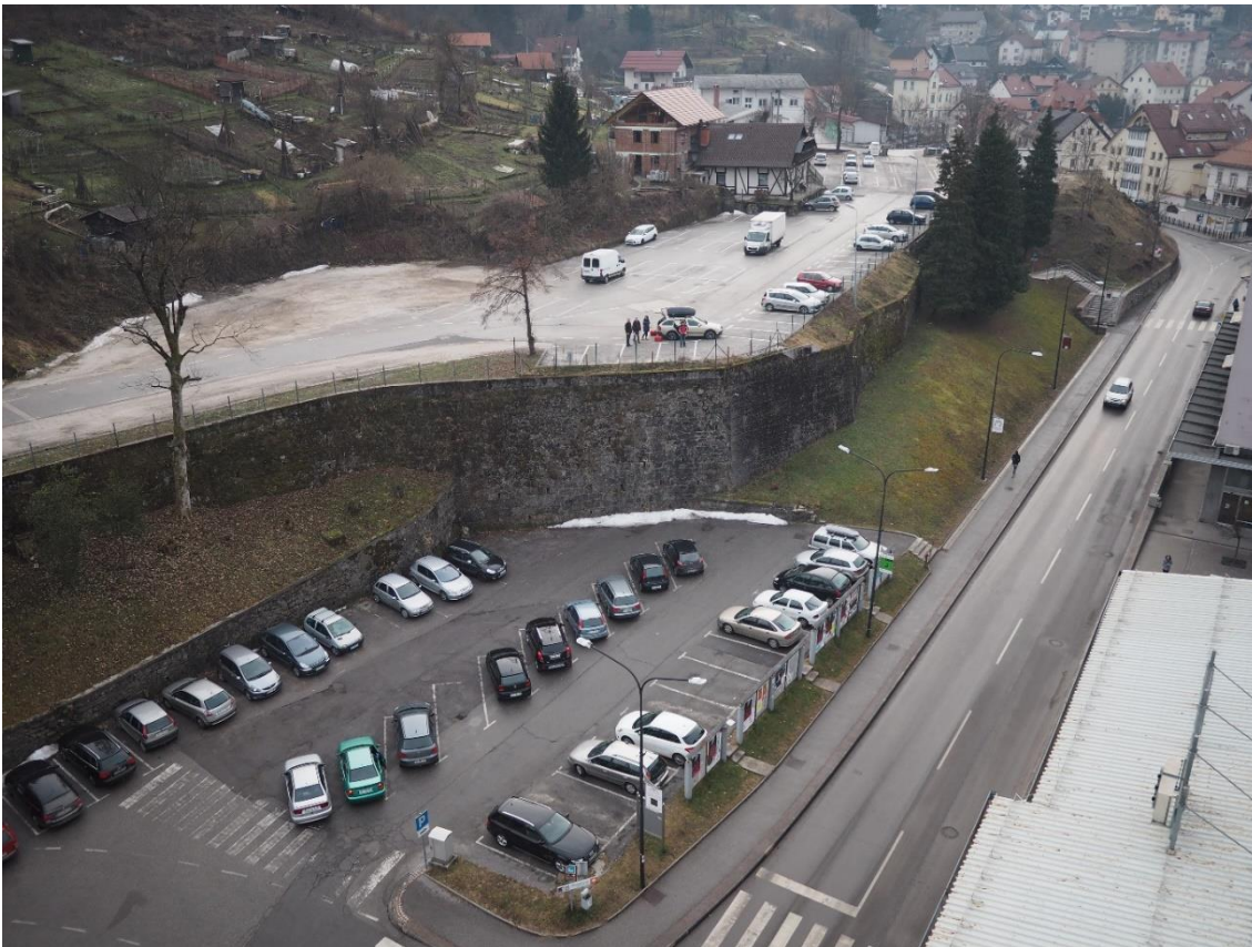
Slika 4: Območje izgradnje nove stavbe. Desno Lapajnetova ulica. Zgoraj pobočje hriba Smukovše. [15].
