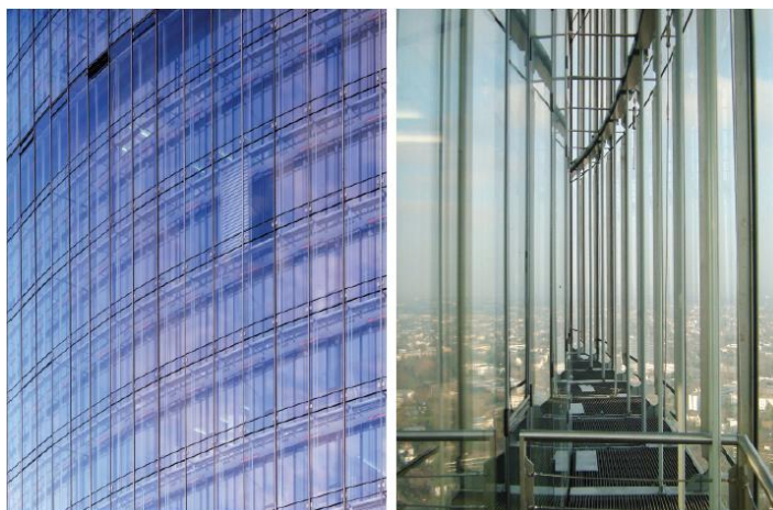
Slika 18: Severna fasada in odprtina med slojema steklene fasade [38].
