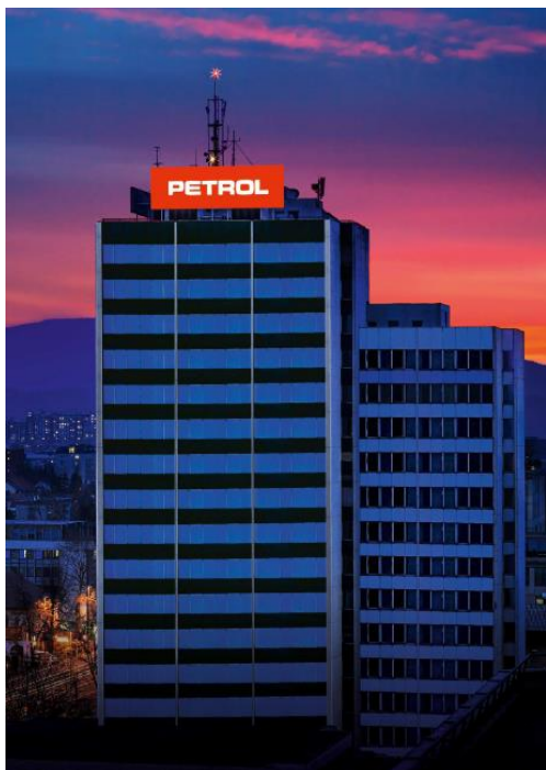
Slika 24: Pogled na južno fasado obravnavane poslovne stavbe [67].
