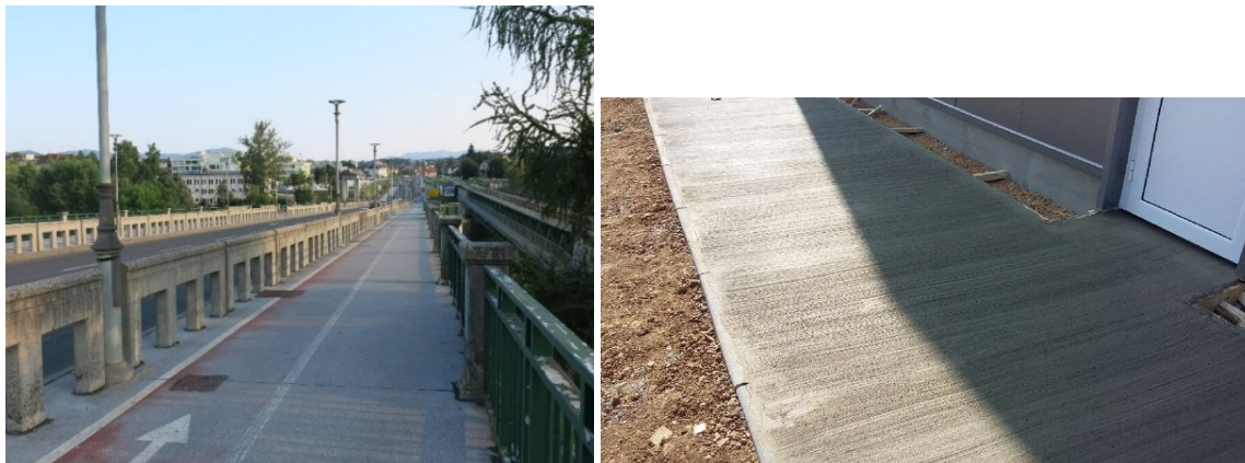
Slika 11: Asfaltna površina pločnika na Kandijem mostu (levo), ščetkan beton [8] (desno)
