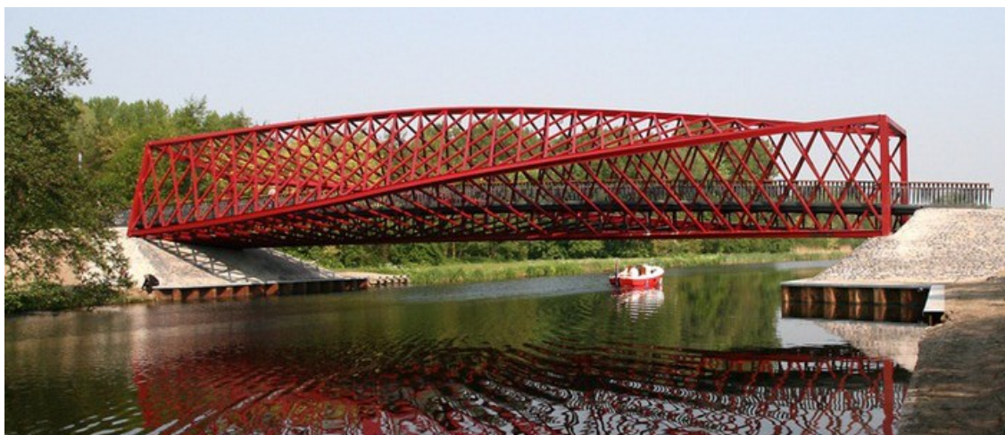
Slika 24: Primer zanimive uporabe prostorskega paličja, most Twist Bridge [10]
