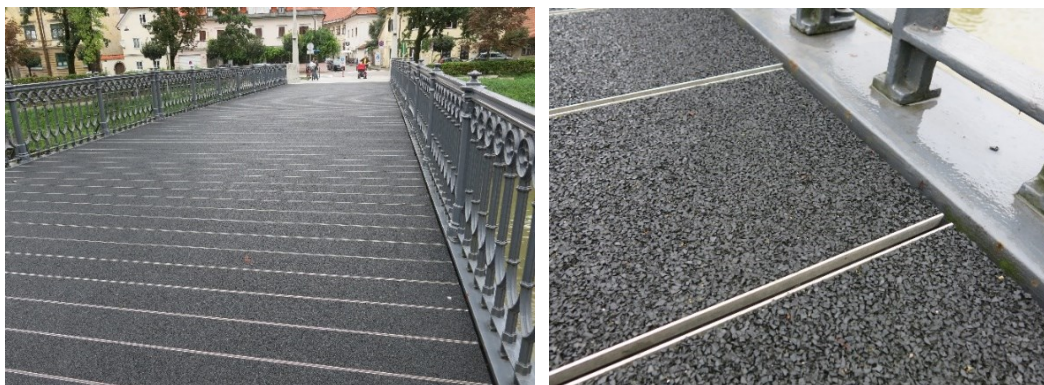
Slika 13: Krovna površina Hradeckega mostu iz poliuretana
