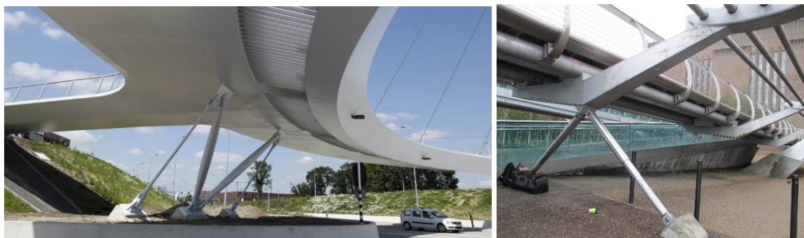
Slika 28: Stabilizatorji pri mostnih konstrukcijah. Hovenring [11] (levo) in Millenium Bridge (desno)
