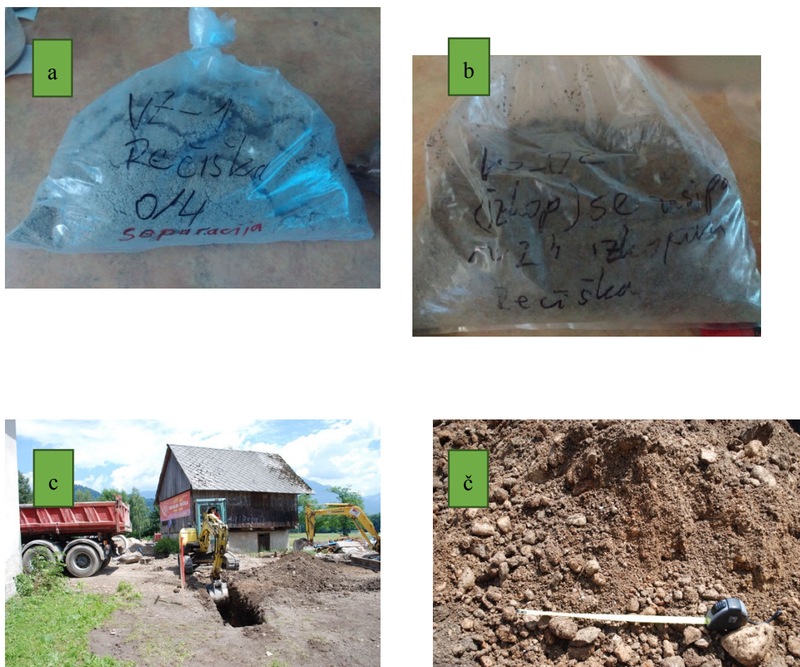
Slika 19 a) vzorec (obsip) VZ-1 b) vzorec (izkopana zamljina) VZ-2 c) lokacija odvzema vzorca VZ-2 č) izkopana zemljina, odložena na robu jarka (Vir: lastni arhiv)
