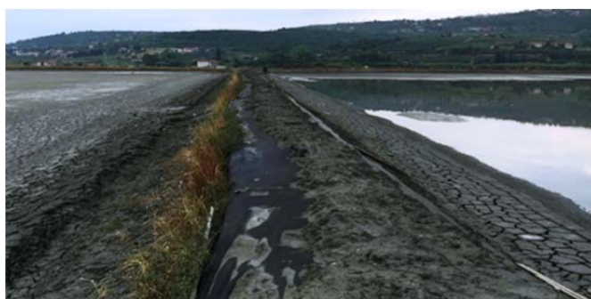
Slika 2.27: Geočrevo, napolnjeno z refulom z dodanim flokulantom (foto: arhiv KMTAL).
