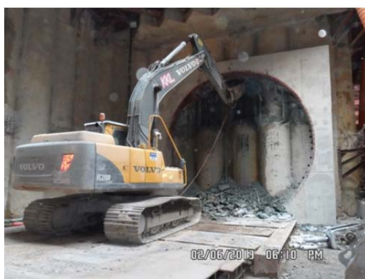
Slika 4-23: Izvedba odprtine v pilotni steni in zaščita z brizganim betonom ( www.asiatunnelling.com ).
