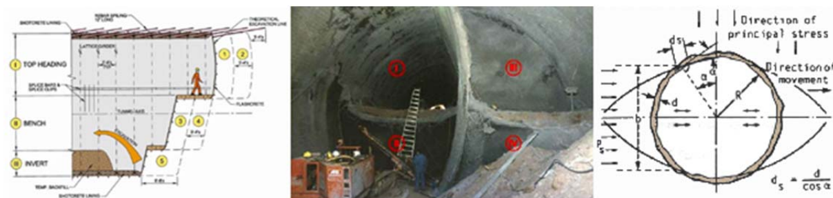
Slika 3-1: Prikaz izvedbe predora po novi avstrijski metodi (levo, sredina) in princip nosilnega obroča (desno) (Maidl et al., 2012).
