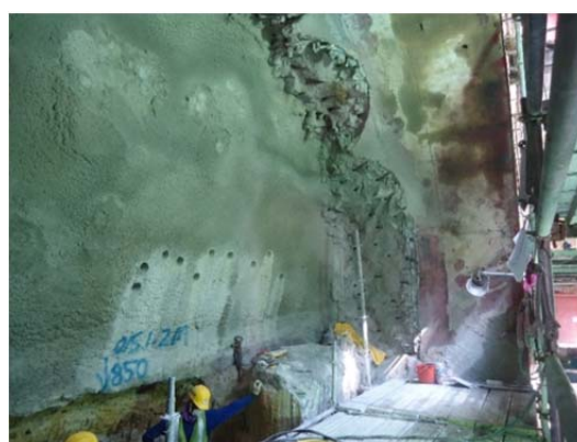
Slika 4-23: Izvedba odprtine v pilotni steni in zaščita z brizganim betonom ( www.asiatunnelling.com ).
