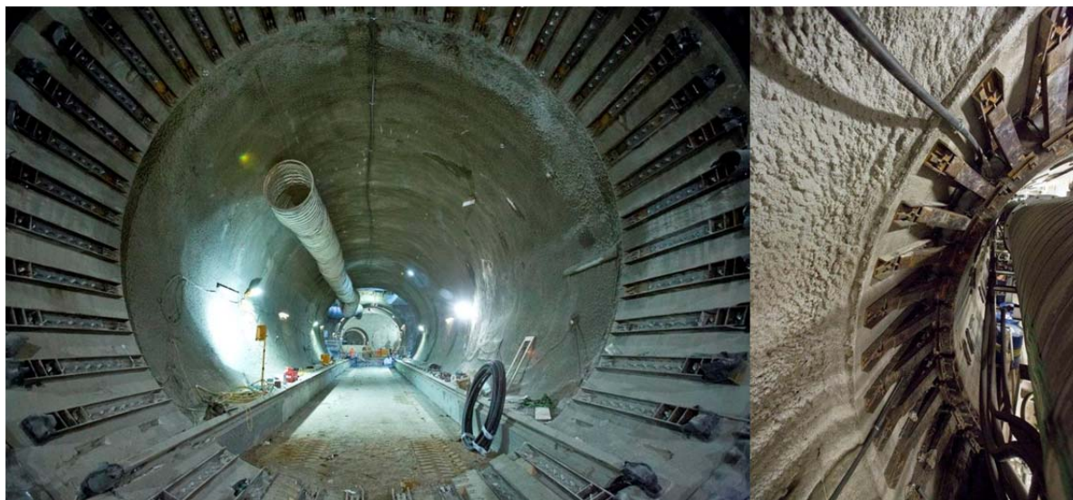
Slika 4-20: Jeklena oporna konstrukcija za start TBM naprave (Schmidt et al., 2014).
