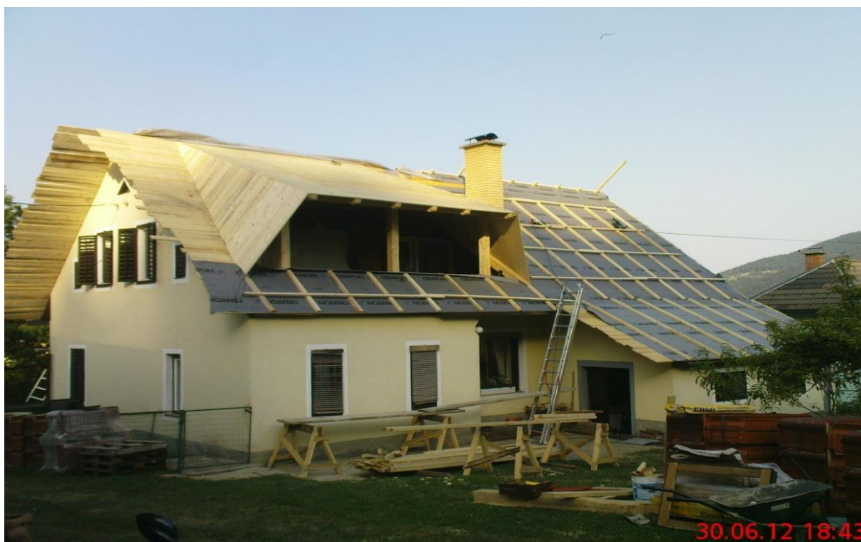
Slika 13: Prenova strehe in povečanje frčade leta 2012
