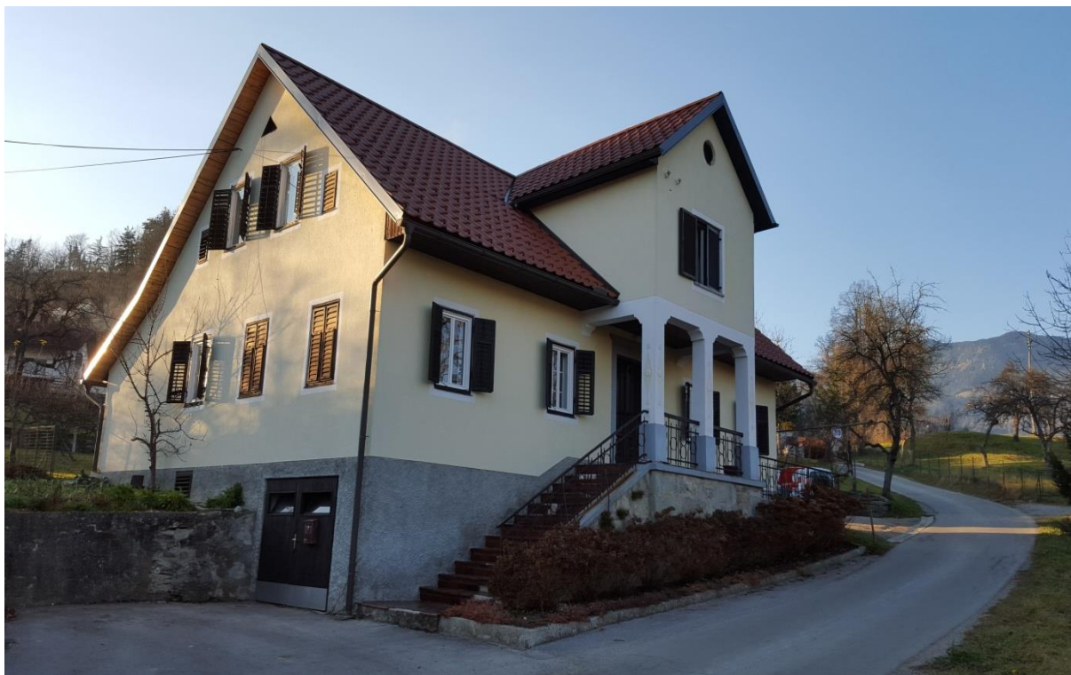
Slika 7: Vzhodna in severna fasada obravnavane hiše
