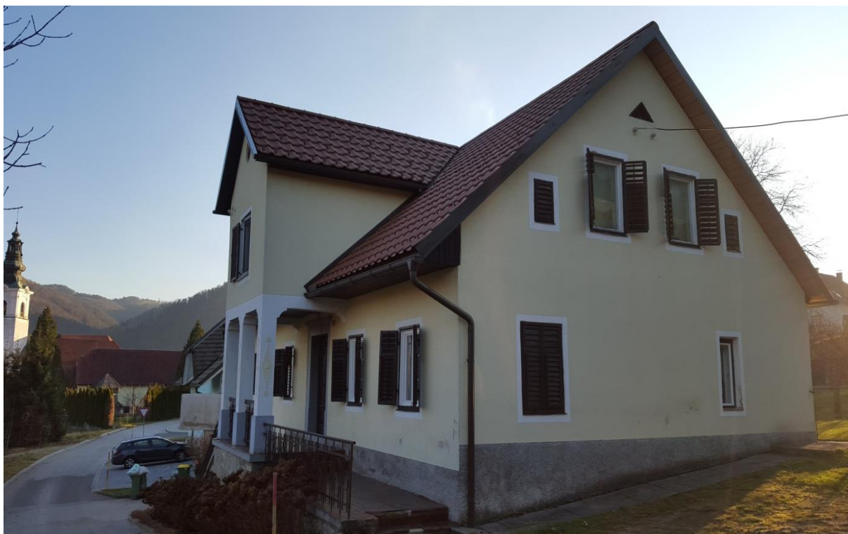
Slika 8: Zahodna in severna fasada obravnavane hiše
