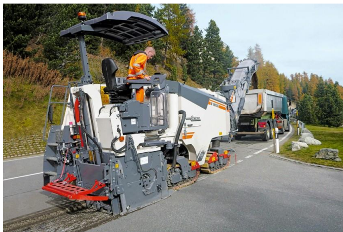
Slika 6 Asfaltni rezkalnik v delu (vir: www.wirtgen.com )
