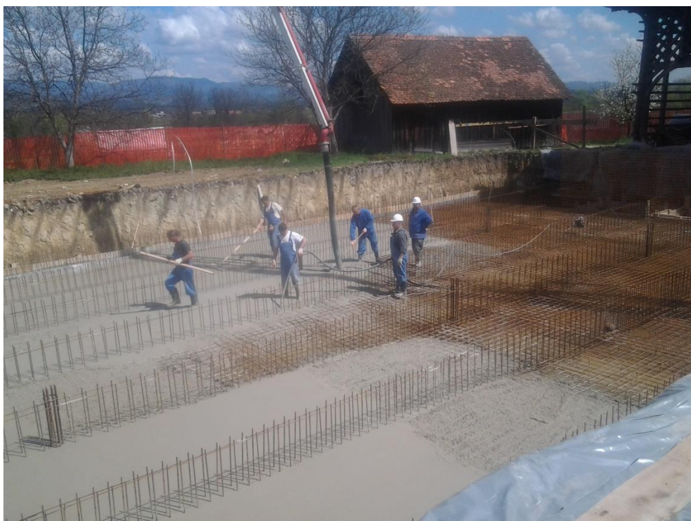
Slika 15: Betoniranje temeljne plošče
