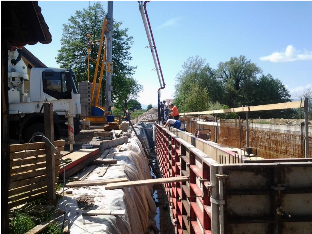
Slika 16: Opaž armiranobetonskih sten
