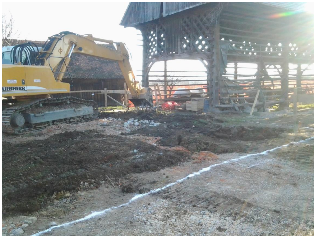
Slika 13: Začetek izkopa gradbene jame
