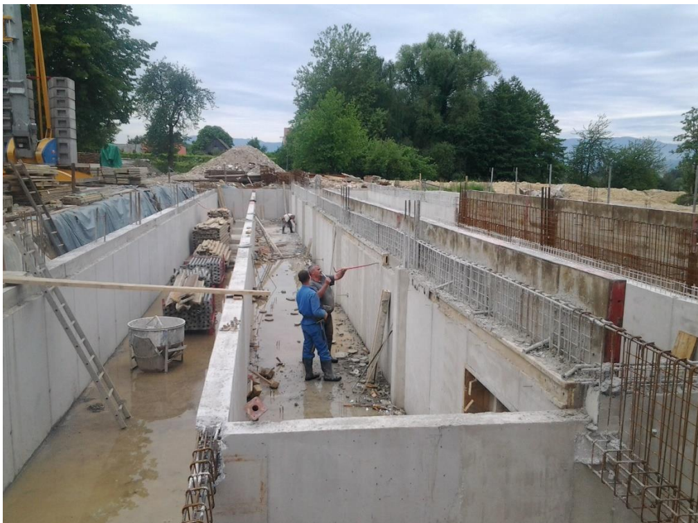
Slika 17: Armiranobetonske stene
