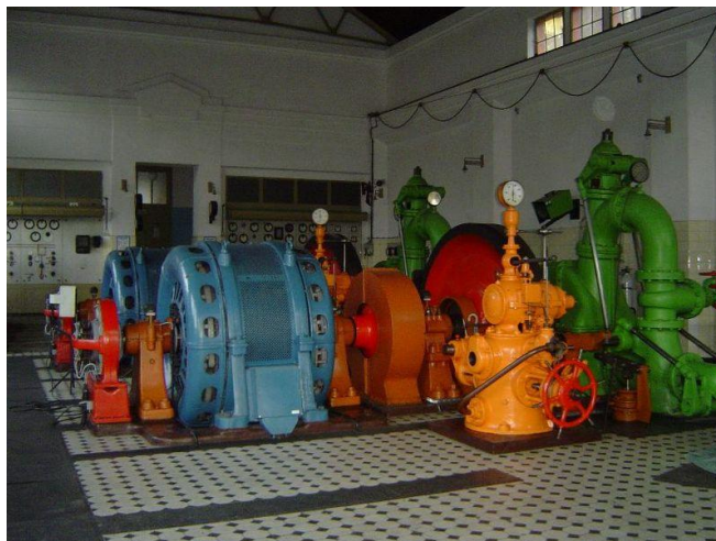
Slika 6: Strojnica HE Završnica, danes zavarovana kot tehnični spomenik.
