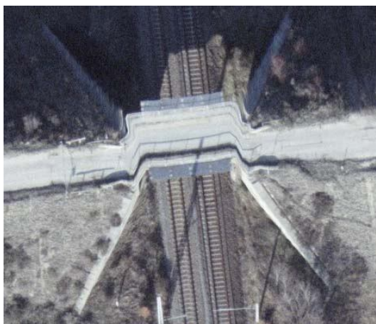
Slika 2.7: Deformiran most na ortofotu [Nodic GmbH]
