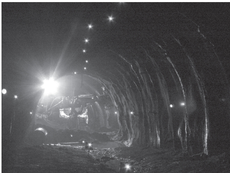
Pogled iz stojišča inštrumenta proti čelu predora, kjer so vidni gradbeni stroji (Marjetič et al., 2006, str. 14)
