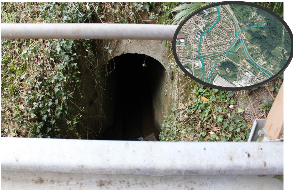
Slika 3: Vtok v cev pod zemljo, ki je speljana do Vrtojbe (foto: Ivo Pertot)
