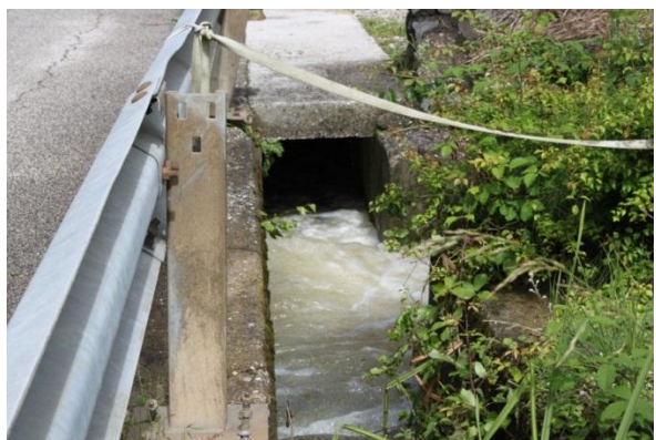
Slika 18: Kanal pod dovozom na dvorišče 15.6.2016 ob 11:00 (foto: Ivo Pertot)
