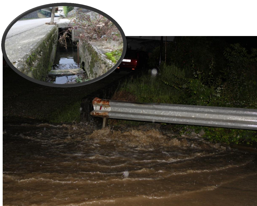
Slika 8: Poplavljen peskolov pred vtokom v kanal ob cesti ob poplavi 15.6.2016 (3:00) (foto: Ivo Pertot)
