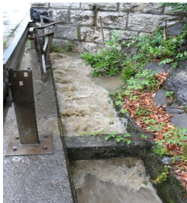
Slika 15: Prepust pod cesto ob visoki vodi 11.6.2016, ko se voda še ne preliva čez (foto: Ivo Pertot)
