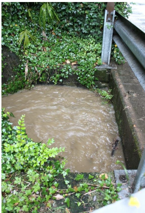
Slika 20: Iztok iz prepusta pod cesto ob visoki vodi 11.6.2016 (foto: Ivo Pertot)
