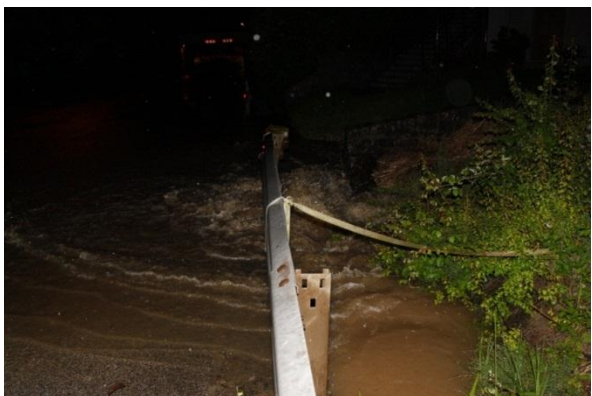
Slika 16: Kanal pod dovozom med poplavo okoli 3:00, 15.6.2016 (foto: Ivo Pertot)
