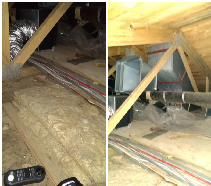
Slika 14 Izolacija podstrešja
