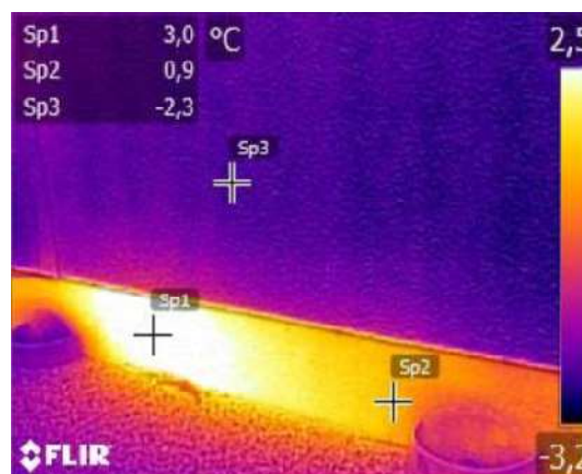
Slika 22: Nevidna poškodba (leva slika), termografska slika nevidne poškodbe (desna slika).
