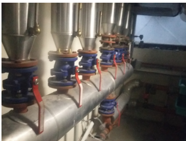
Slika 17: Ventili ogrevalnega sistema.
