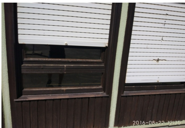
Slika 27: Primer okna v vrtcu Postojna.
