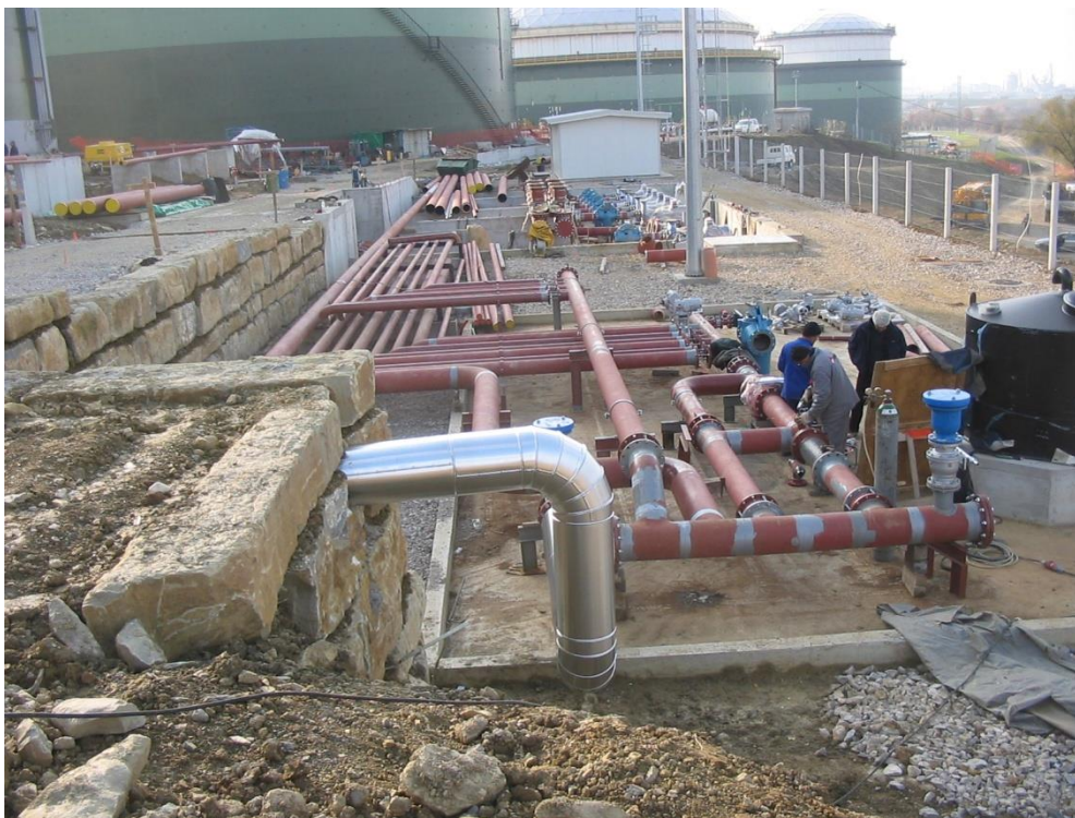
Slika 19: Prikaz postavljenih tehnoloških cevovodov.
