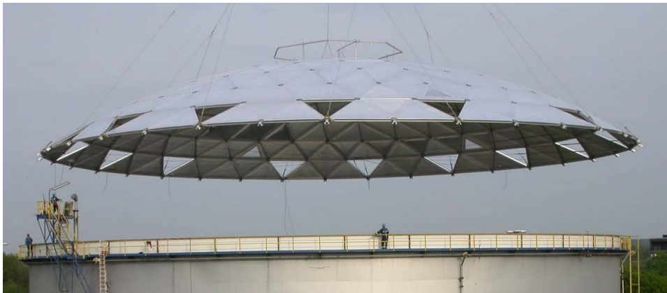
Slika 13: Prikaz fiksne aluminijaste strehe med montažo na jekleni plašč rezervoarja.
