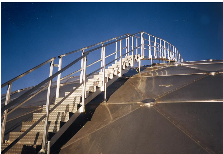
Slika 14: Prikaz dostopa do vrha rezervoarja preko jeklenih stopnic.
