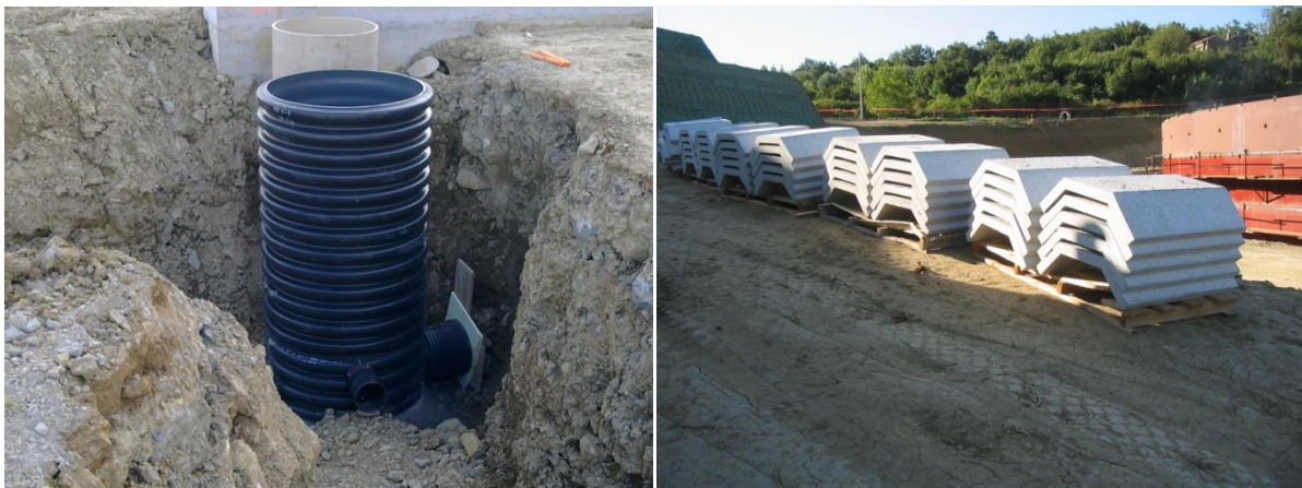
Slika 12: Prikaz revizijskega jaška in kanalet.
