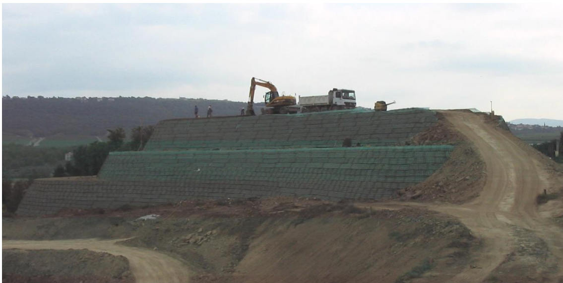
Slika 17: Prikaz izvedenega protipožarnega nasipa.
