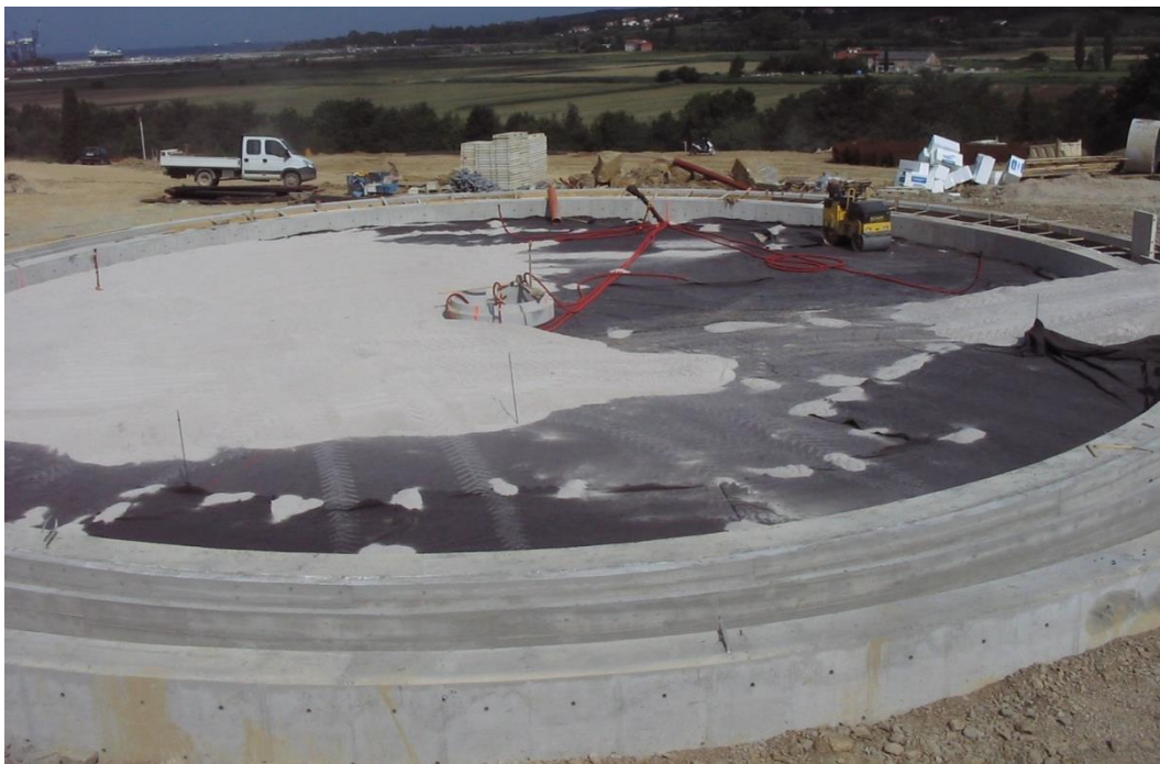
Slika 15: Prikaz izvedenega temelja za rezervoar.
