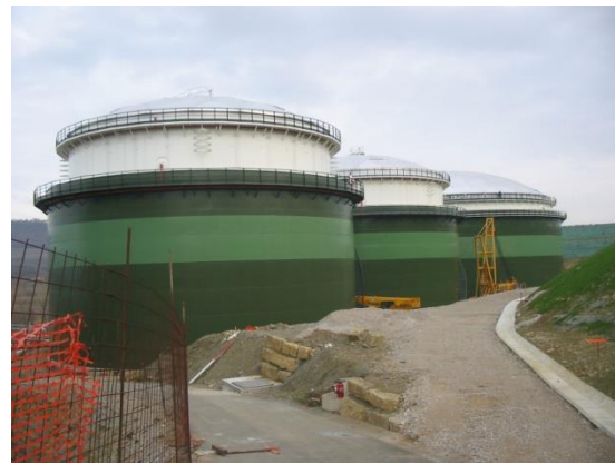
Slika 16: Prikaz montaže rezervoarja in končne izvedbe montiranih rezervoarjev.
