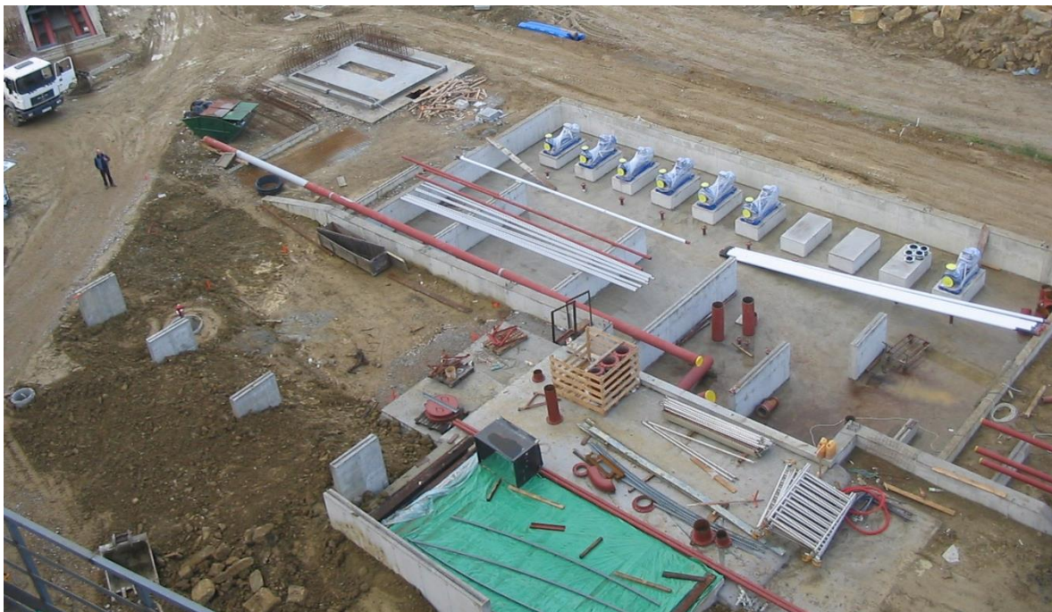
Slika 18: Prikaz izvajanja črpališča Č5 s prepustom.
