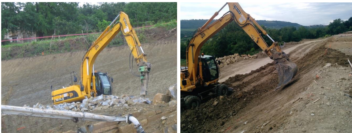
Slika 9: Prikaz bagerja s strojnim kladivom in bager
