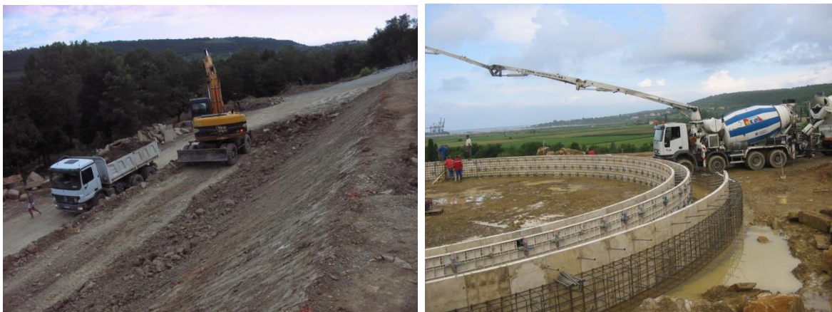
Slika 10: Prikaz tovornega vozila in avtomešalec s črpalko za beton.
