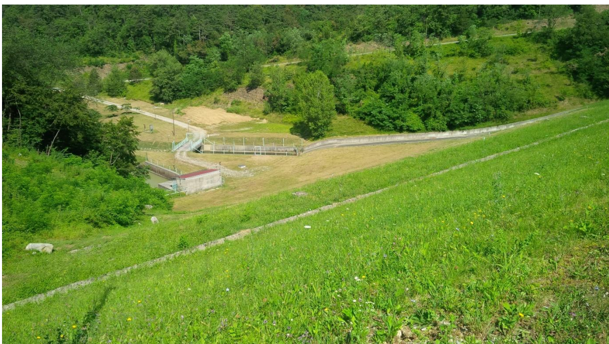
Slika 7: Zračni del pregrade, prekrit z rodovitno zemljo
