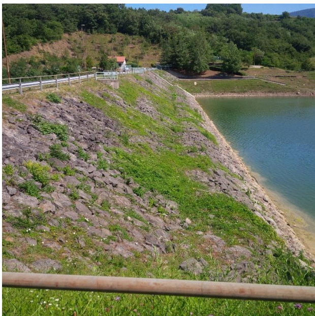
Slika 5: Skalomet na vodni strani pregrade
