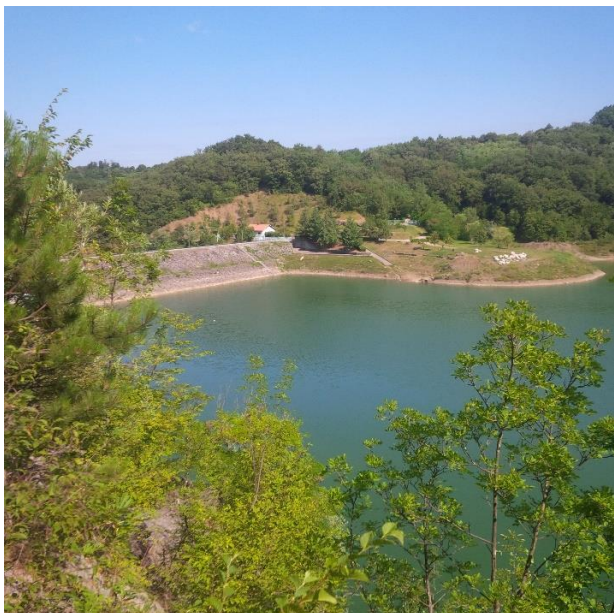
Slika 4: Pogled na pregrado Vogršček
