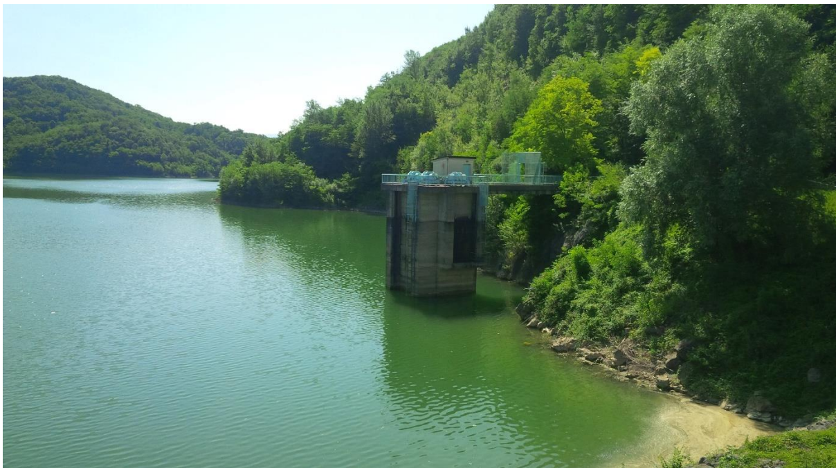
Slika 8: Odzemni objekt za vodo za namakanje
