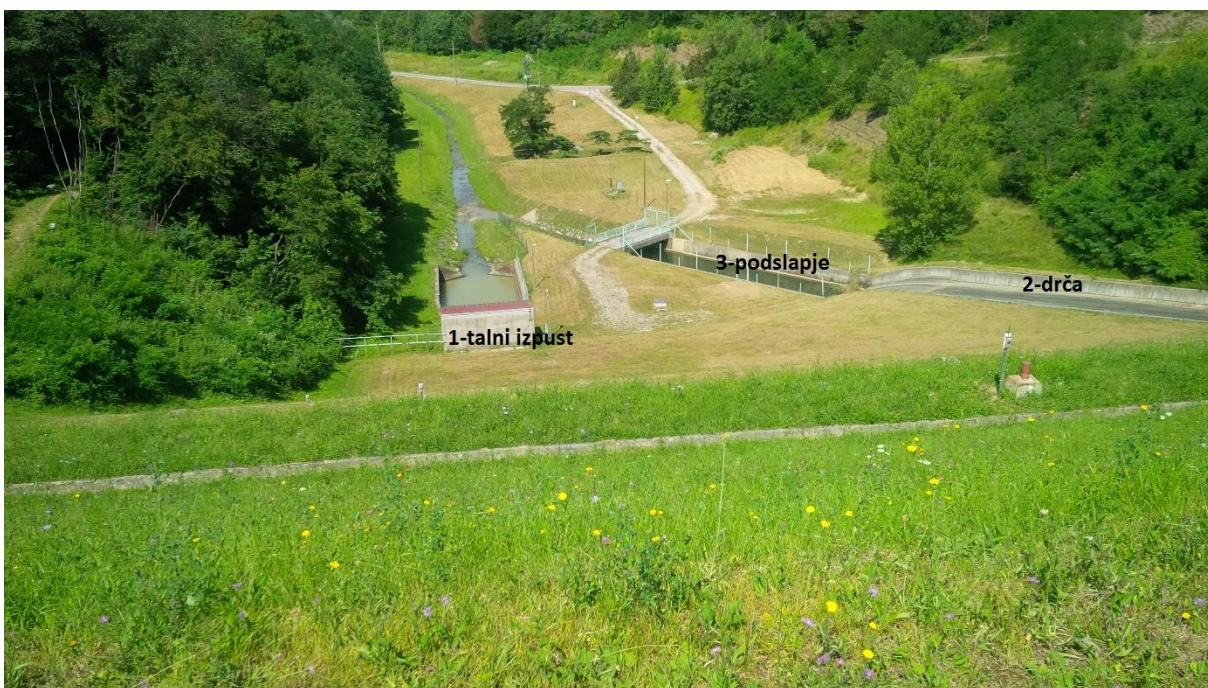
Slika 9: Pobočje pregrade na zračni strani (1-talni izpust, 2-drča in 3-podslapje)
