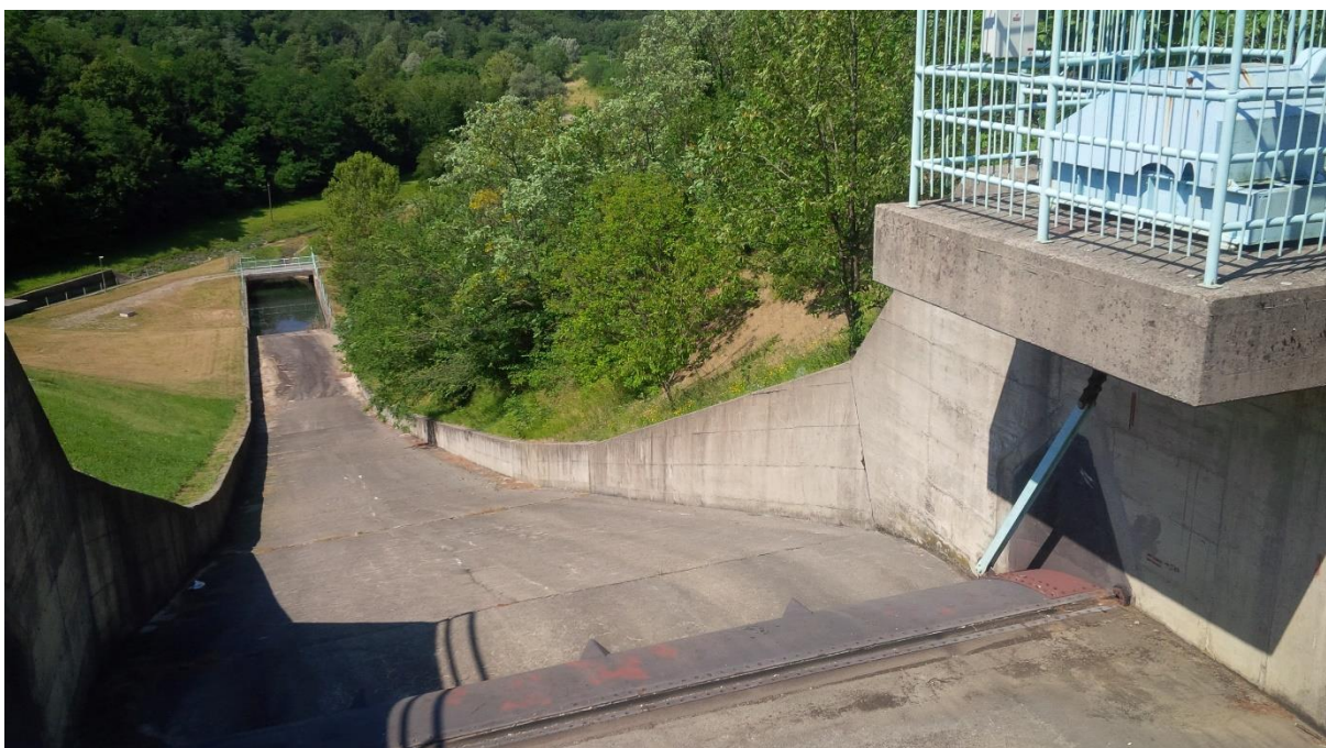
Slika 11: Zaklopka na temenu preliva in drča
