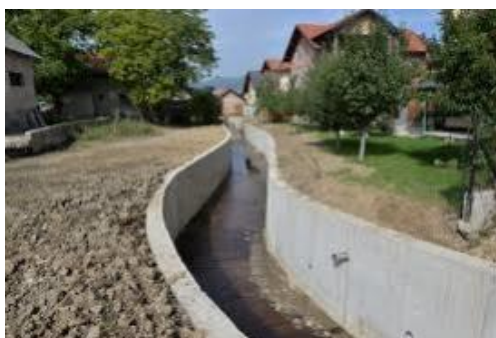
Slika 2: primer gladkega obrežnega zidu (Gunzek, M., Burger, J., 2016)
