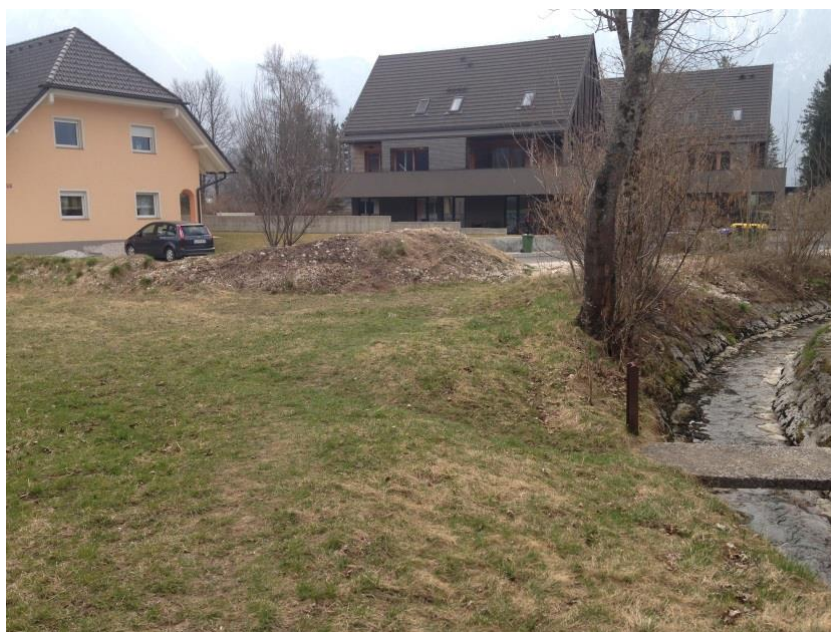
Slika 10: zemeljski nasip, ki usmerja vodo iz polja nazaj v strugo potoka (avtor, terenski ogled 21.3.2016)
