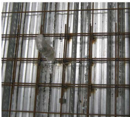
Slika 33: Prekrivanje armaturnih mrež v sovprežni plošči [7]
