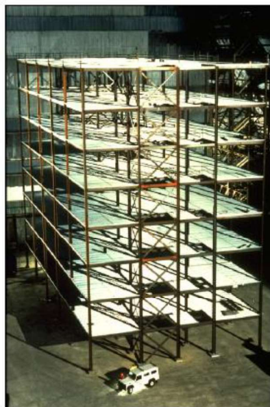
Slika 3: Testna zgradba v okviru raziskovalnega programa Cardington [7]
