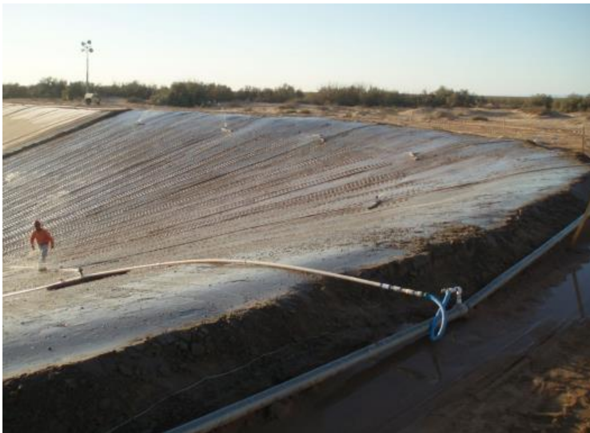
Slika 9: nega cementirane zemljine s pršilci [5]
