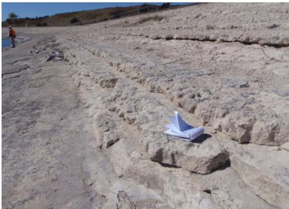
Slika 1: primer gorvodne erozijske zaščite s cementirano zemljino na Merritt dam [5]
