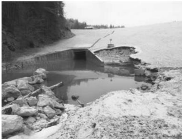
Slika 3: Iztok iz talnega prepusta pregrade septembra 2010 (Humar, Kryžanowski, 2012)
