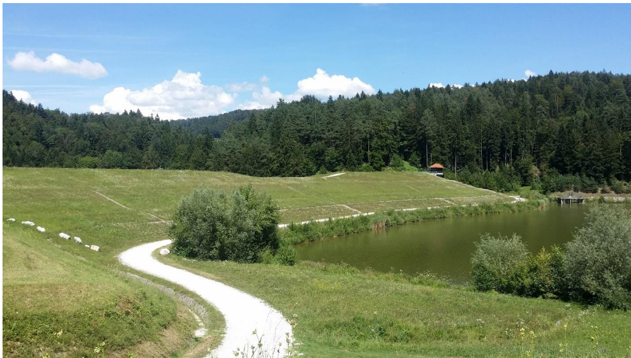
Slika 5: Vodna stran pregrade Drtijiščica
