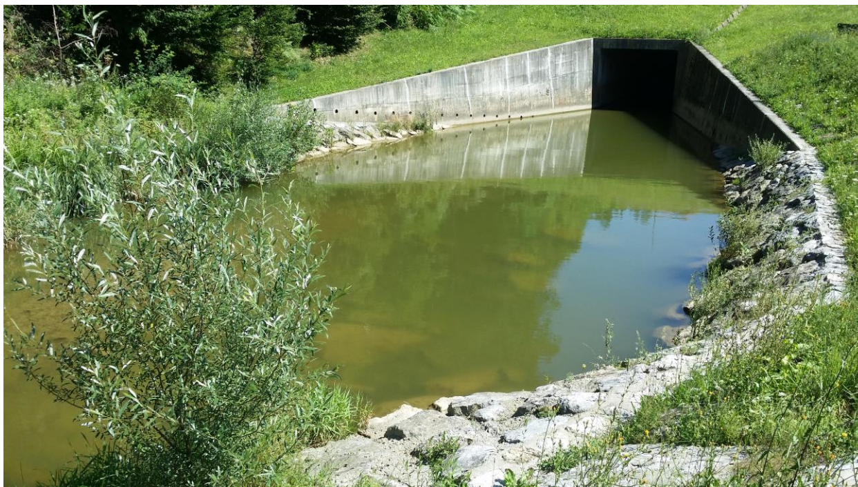
Slika 11: Talni izpust in podslapje pregrade
