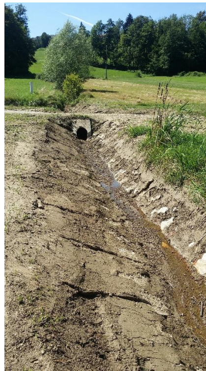
Slika 10: Čiščenje odvodnega jarka za meteorne vode na zračni strani pregrade
