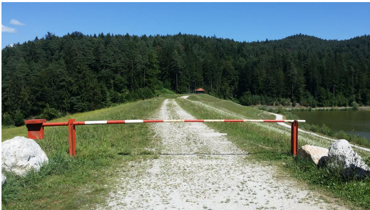
Slika 8: Rampa, ki preprečuje dostop motornim vozilom do pregrade
