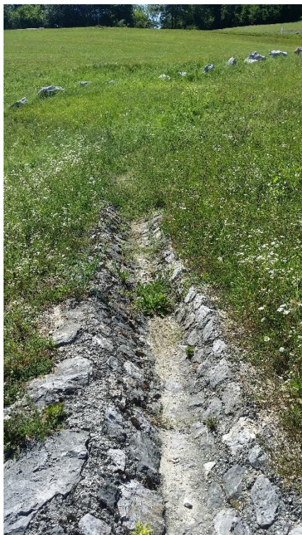
Slika 9: Kanalete na telesu pregrade
