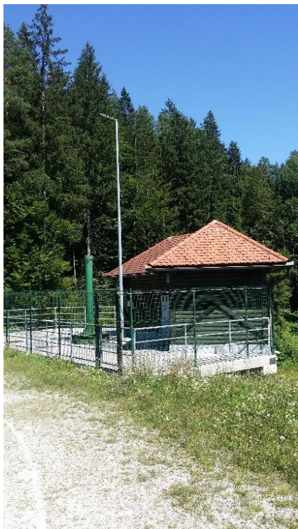
Slika 12: Kontrolna hišica na kroni pregrade
