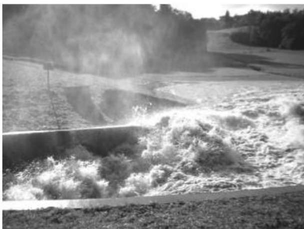
Slika 4: Erozijska zajeda levega brega podslapja septembra 2010 (Humar, Kryžanowski, 2012)
