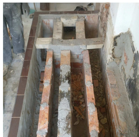
Slika 11: Dobro vidni kanali v osrčju lončene peči.
