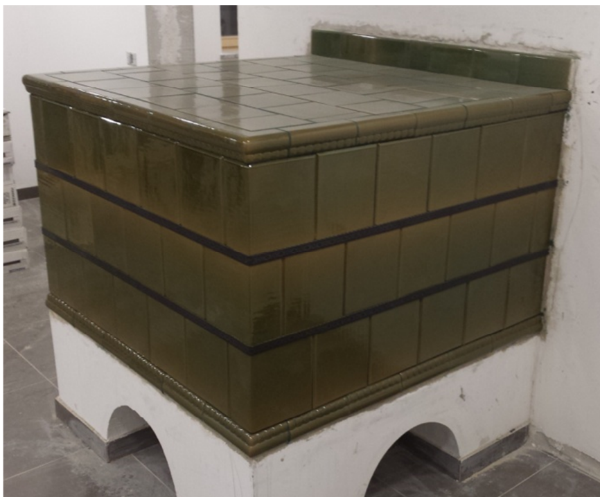
Slika 15: Primer krušne peči, ki ogreje vsaj 40m 2 ob toplotnih izgubah 80 W/m 2 , (IC TNP Bohinj)
