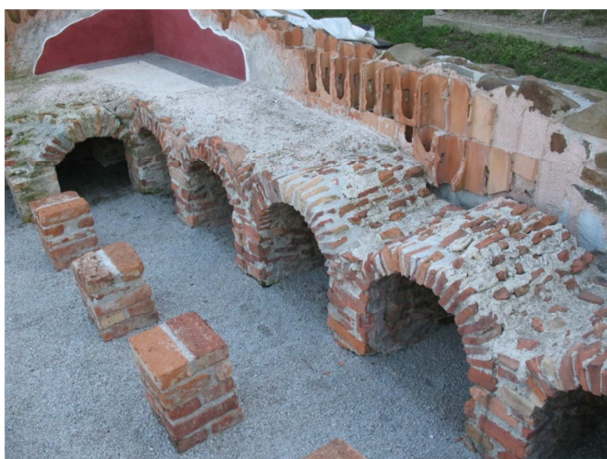
Slika 5: Oboki so omogočali prehod toplemu zraku.
