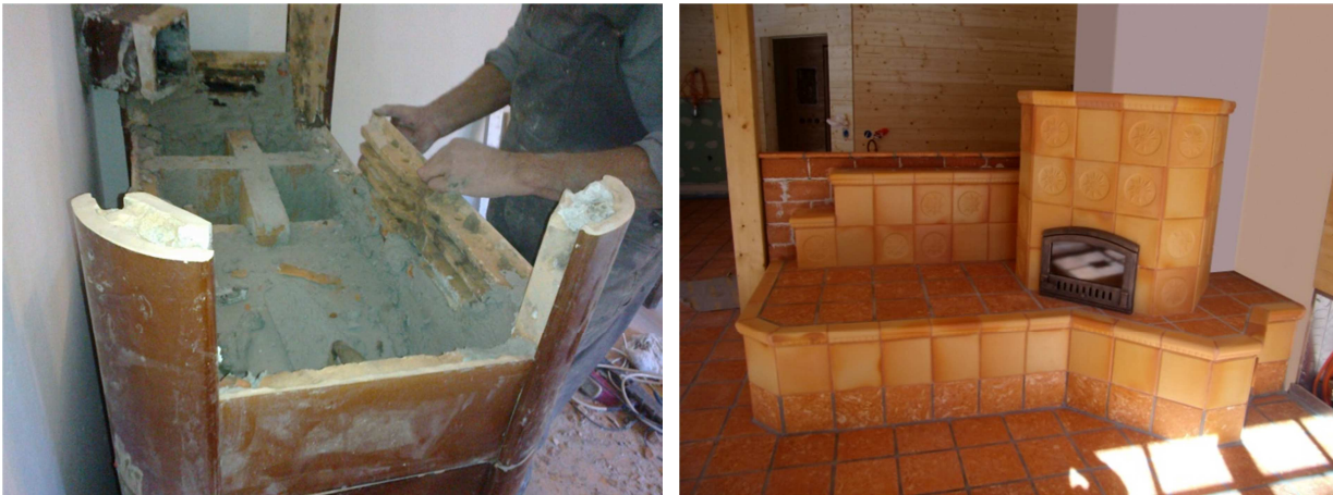
Slika 12: Na levi samostoječi kamin, na desni pa razgiban ležalni kamin s turnom, naslonom in steklenimi vratci.
