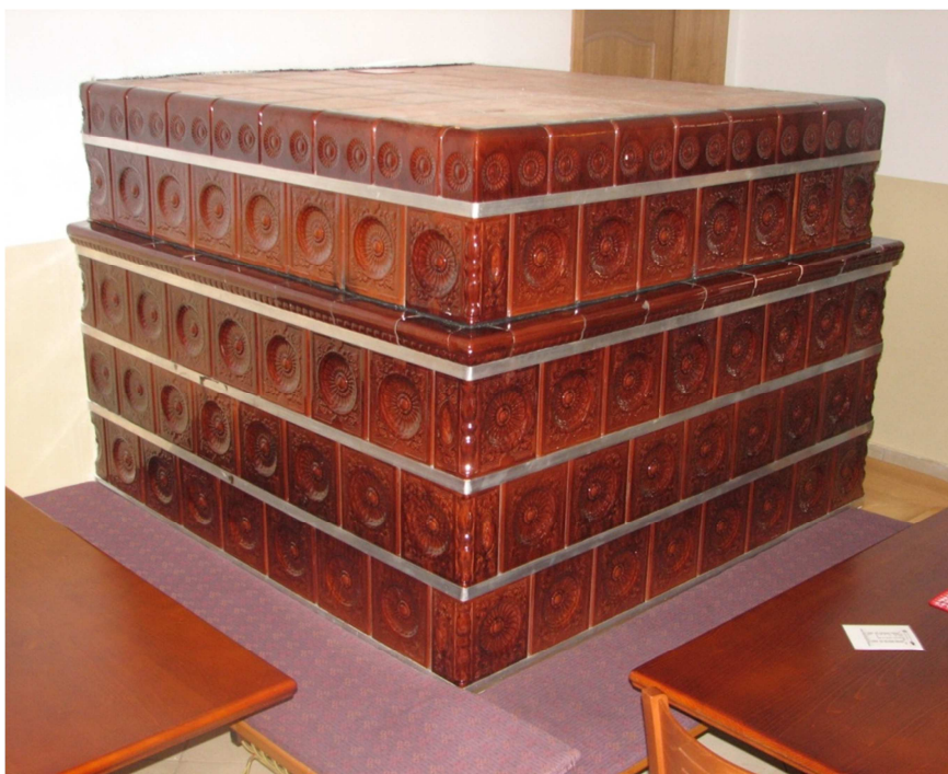
Slika 16: Planinski dom nad Moravčami večinsko ogreva lončena krušna peč. Površina plašča te peči je 9,84 m 2 .
