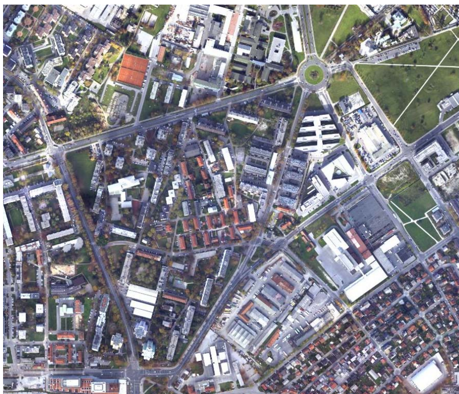
Slika 3: Soseska Savsko naselje, grajena v letih 1957–1972 (Urbinfo MOL, 2016)
