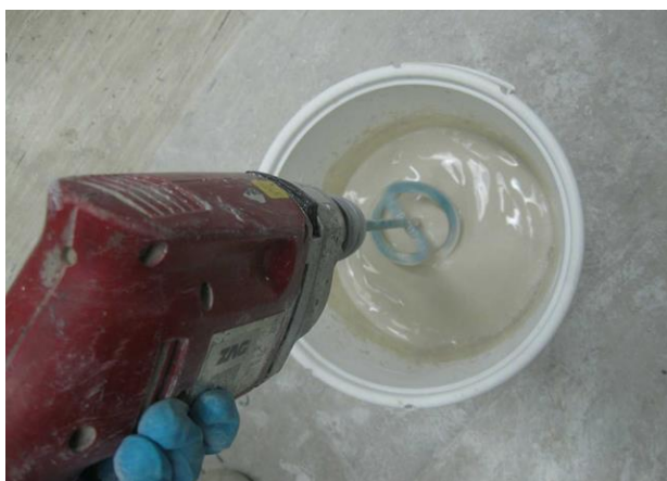
Slika 7: Mešanje injekcijske mase
