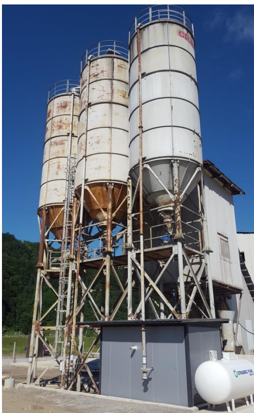
Slika 21: Silosi na cement [16]
