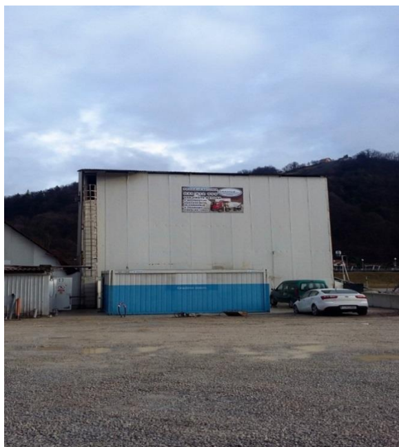
Slika 8: Linijski silosi za agregat, ki so zaščiteni z izolacijsko fasado [16]
