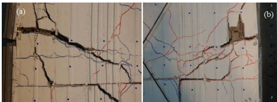
Slika 4: Močne poškodbe na (a) levem in (b) desnem robu stene. Vidni sta veliki diagonalni razpoki (Dolšek, Gams, Bohinc, Kramar in Snoj, 2016)
