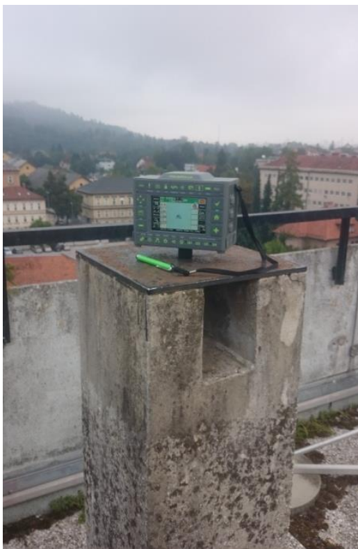
Slika 6: Prikaz delovišča na strehi FGG, steber FGG 1
