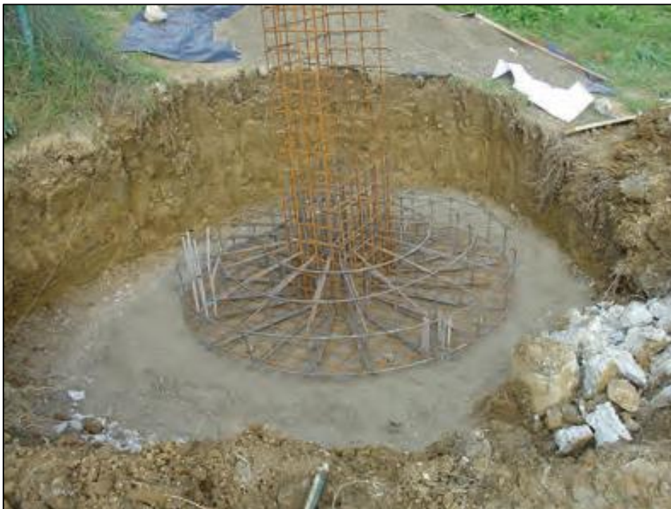
Slika 3: Prikaz armiranja antenskega stebra na točki Kog (Medved, 2014, str. 781).
