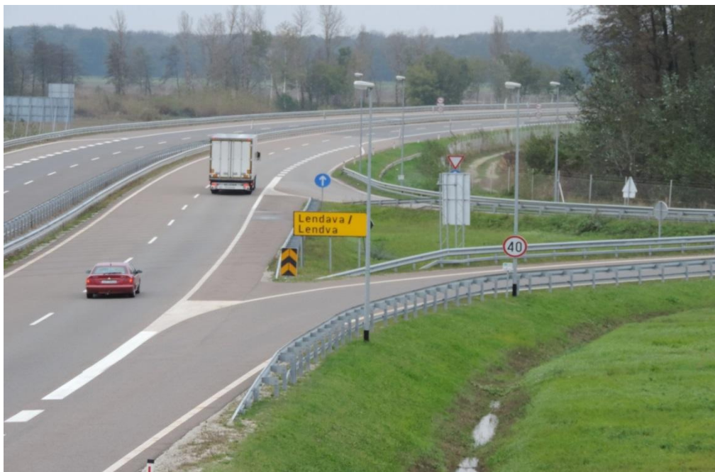
Slika 33: Primer VNP Lendava opremljenega z javno razsvetljavo
