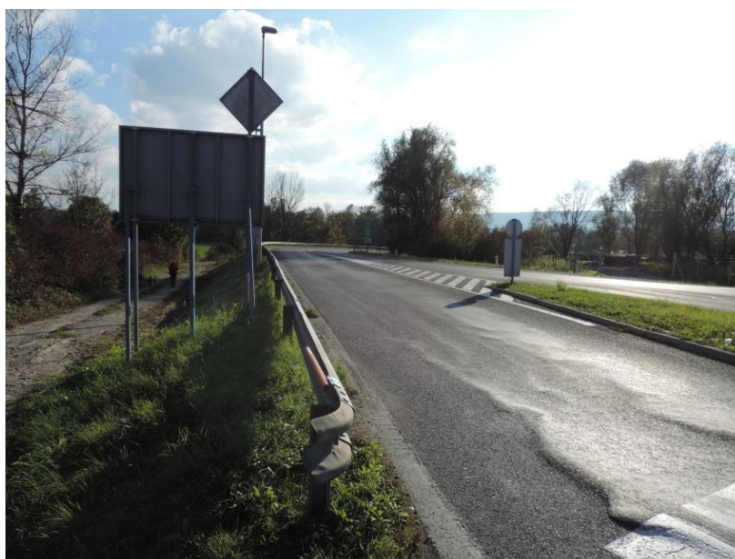
Slika 19: Primer deformacije vozišča na izvozu iz VNK
