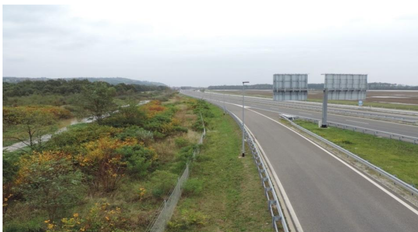
Slika 34: VNV Dolga vas - Primer dobro urejenega VNV s prometno signalizacijo in opremo
