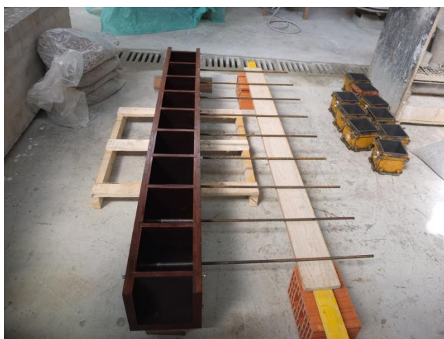
Slika 13: Vstavljanje armaturnih palic v kalup in zagotavljanje primerne sidrne dolžine
