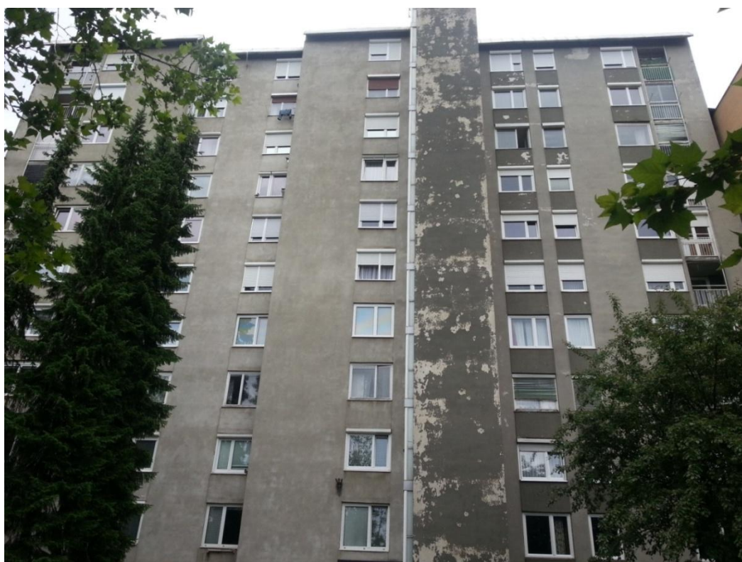
Slika 4: Izgled večstanovanjske stavbe Rašiška 1 pred prenovno
