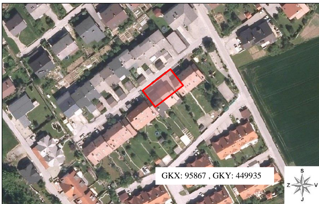
Slika 1: V rdečem okvirju označen obravnavani objekt [vir: 14]
