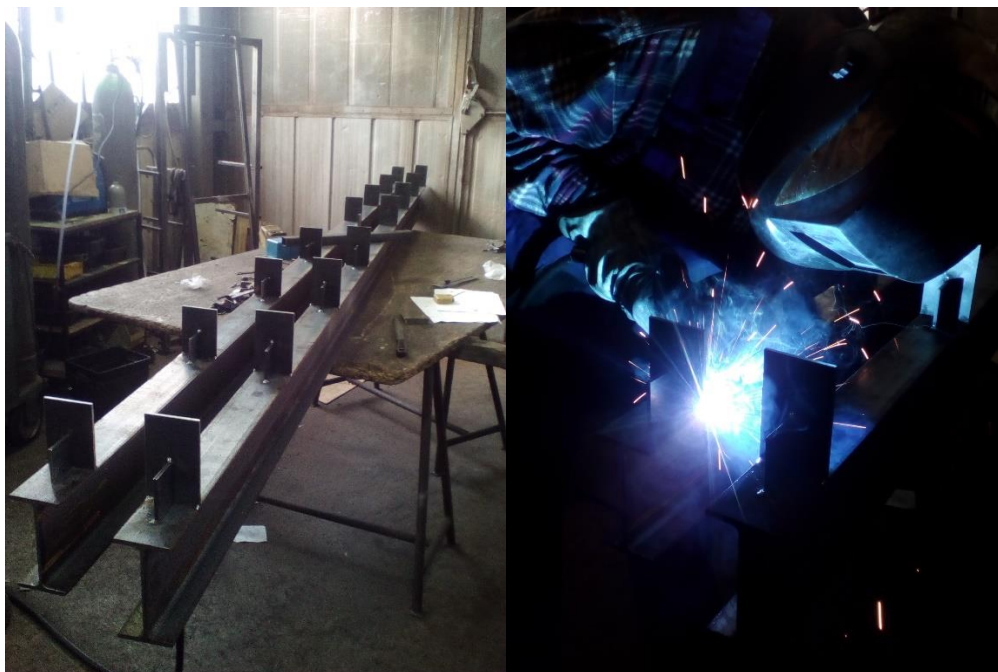
Slika 26: Jekleni nosilci (levo) in varjenje ploščic (desno)
