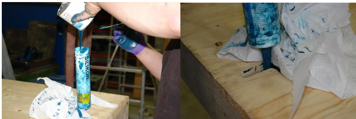
Slika 29: Nalivanje dvokomponentne smole v aplikator (levo) in aplikacija v vtor (desno)
