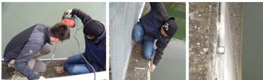
Slika 7: Stabilizacija reperja R24N (Vir: Djurić)
