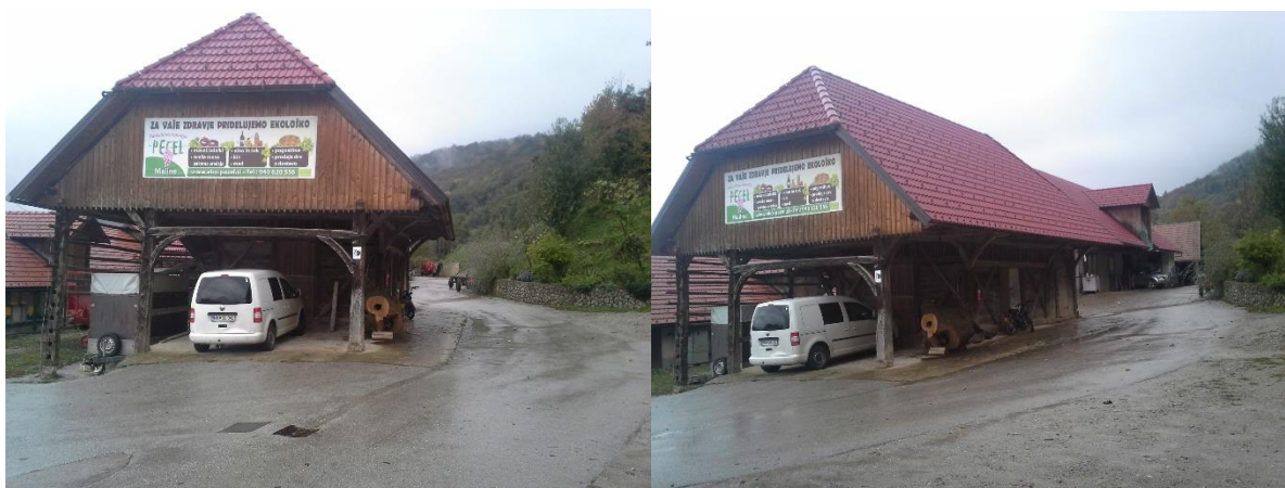
Slik10: Pogled na obravnavani objekt
