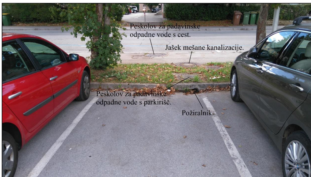
Slika 7: Način odvodnjavanja z javnega parkirišča na Lizkozarjevi ulici v Kranju (osebni arhiv).
