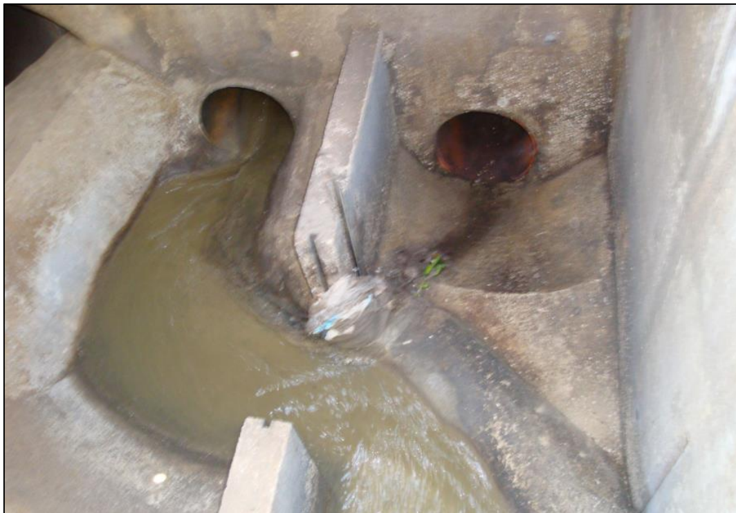
Slika 18: Razbremenilnik pred ZB 5 – pogled na cevno dušilko in razbremenilni kanal (osebni arhiv). Figure 18: Stormwater overflow before ZB 5 (personal archive).
