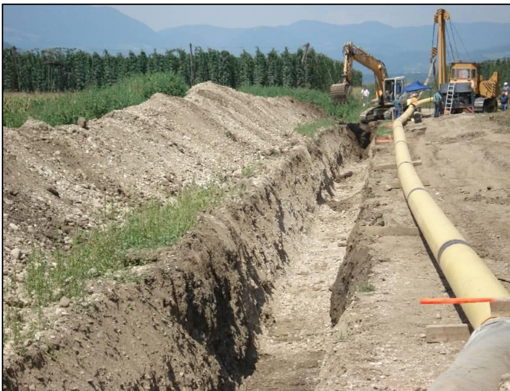
Slika 28: Hkratni potek izkopa jarka in varjenja cevi
