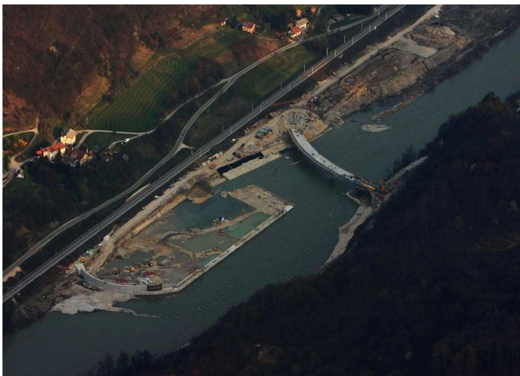
SLIKA 29: Začetek izgradnje hidrolelektrarne Krško (Hess d.o.o.)
