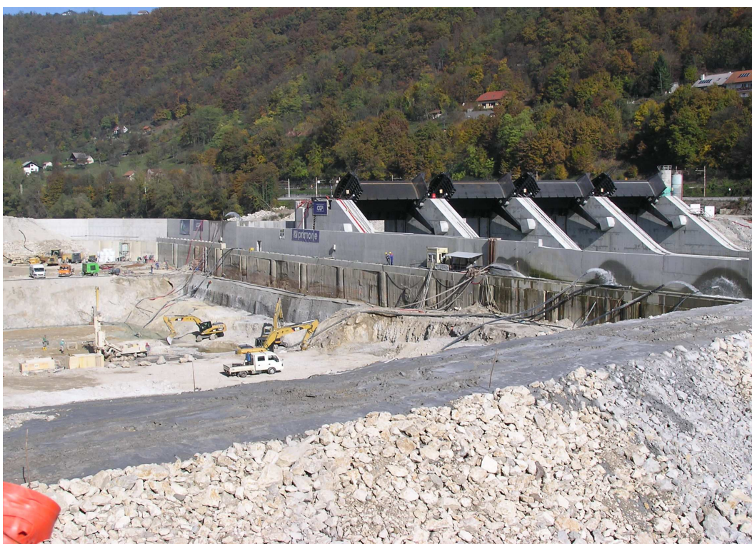
SLIKA 31: Gradnja HE Krško v dveh gradbenih jamah
