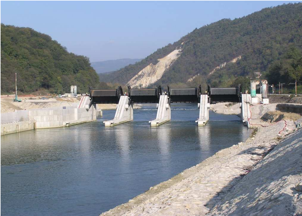
SLIKA 37: Prelivna polja hidrolelektrarne Krško
