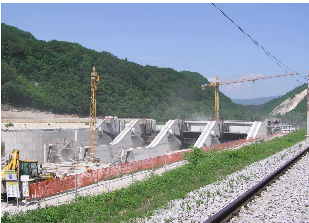
SLIKA 3: Izgradnja Hidroelektrarne Krško
