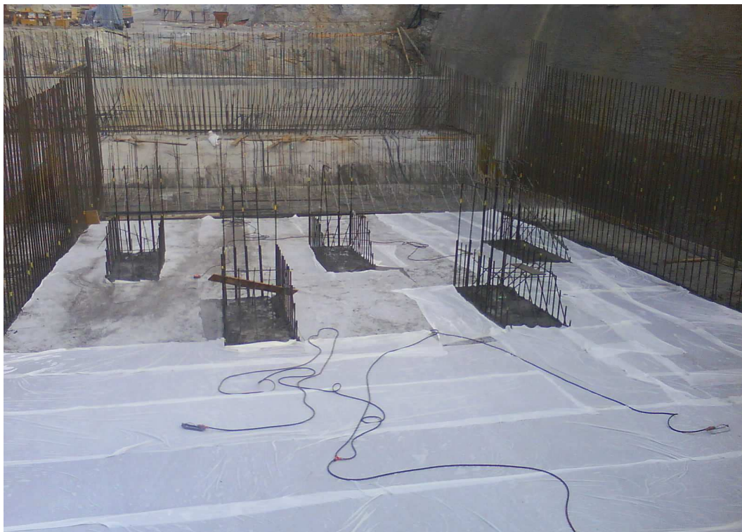
SLIKA 34: Izgradnja razbijačev HE Krško
