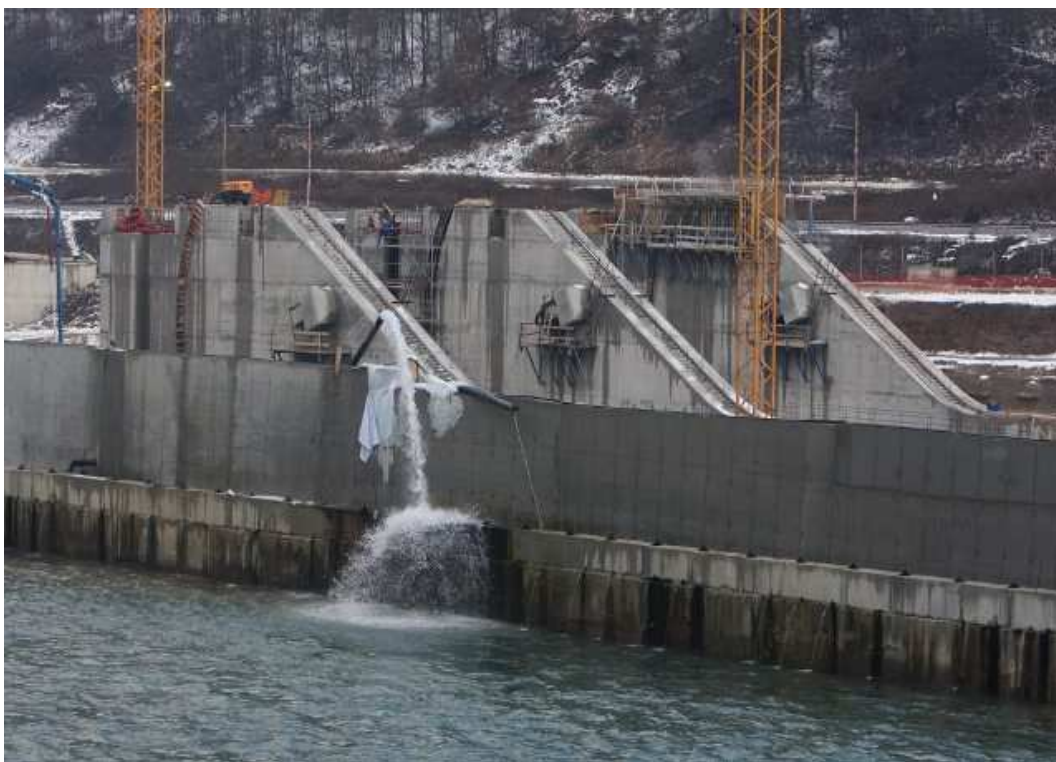
SLIKA 36: Izgradnja prelivnih polj
