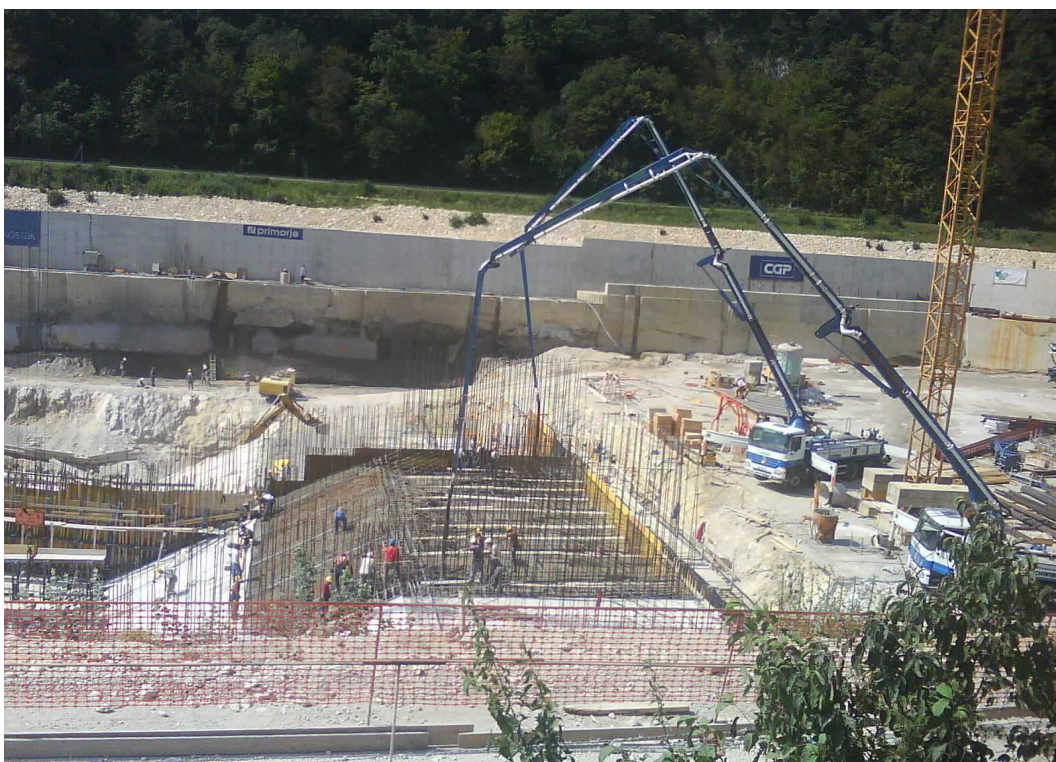
SLIKA 2: Izgradnja Hidroelektrarne Krško
