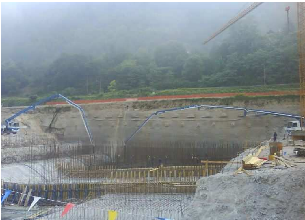
SLIKA 38: Betoniranje s pomočjo betonskih črpalk
