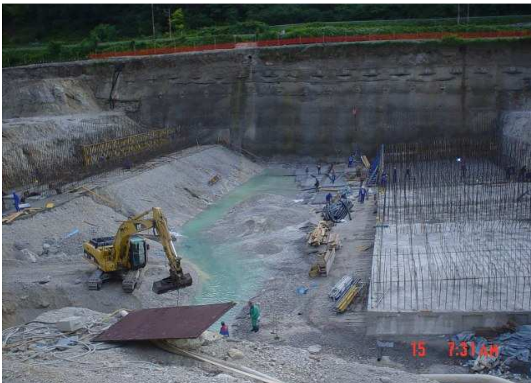
SLIKA 33: Vgrajevanje drenažnih cevi
