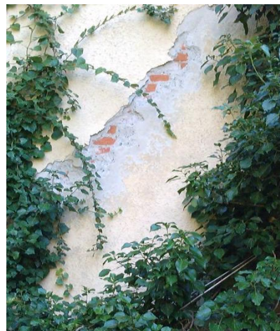
b) diagonalno odpadanje zunanjega ometa
