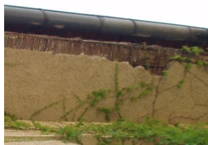
d) ločitev ometa od trstike v napušču
