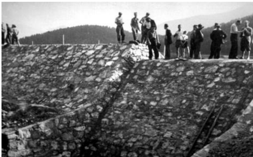
Slika 2: Obnova jezu v Rešetu (1957) [4]
