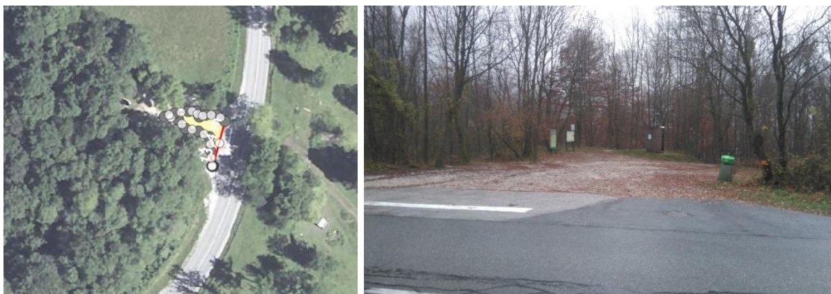
Slika 41: Parkirna površina vstopnega mesta Srpenica 2 (povzeto po Atlas okolja, 2016) Figure 41: Parking space at the entry point Srpenica 2 (adapted after Atlas okolja, 2016)
