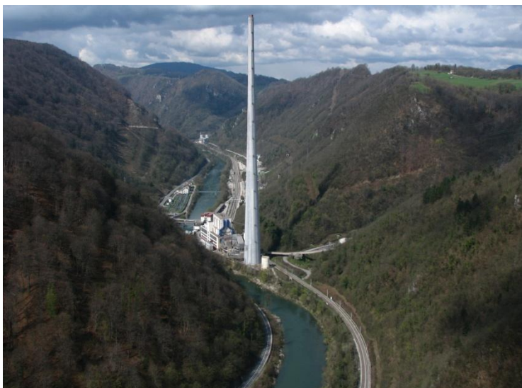
Slika 4: Dimnik termoelektrarne Trbovlje (Trboveljski dimnik, 2016)
