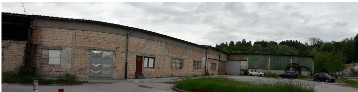
Slika 23: Opuščeni proizvodni in skladiščni prostori na Opekarni
