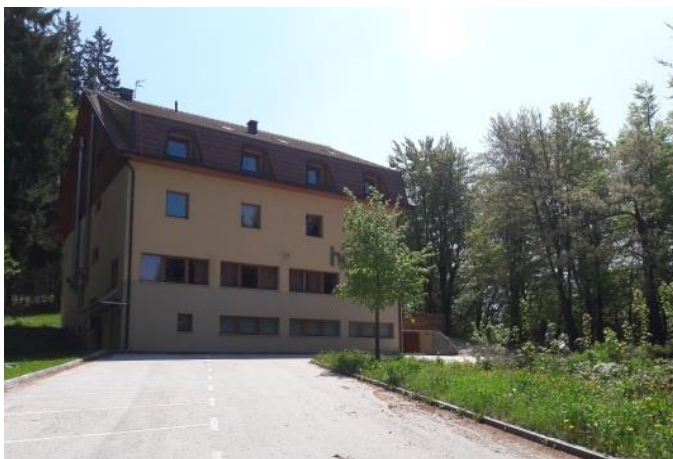
Slika 37: Zapuščen objekt Hotela Dom Utrip
