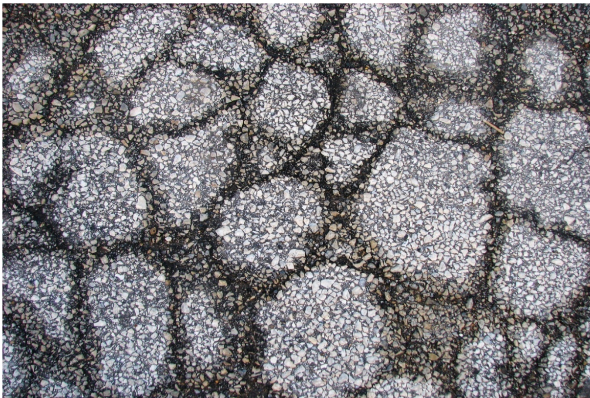
Slika 3: Globoke mrežaste razpoke
