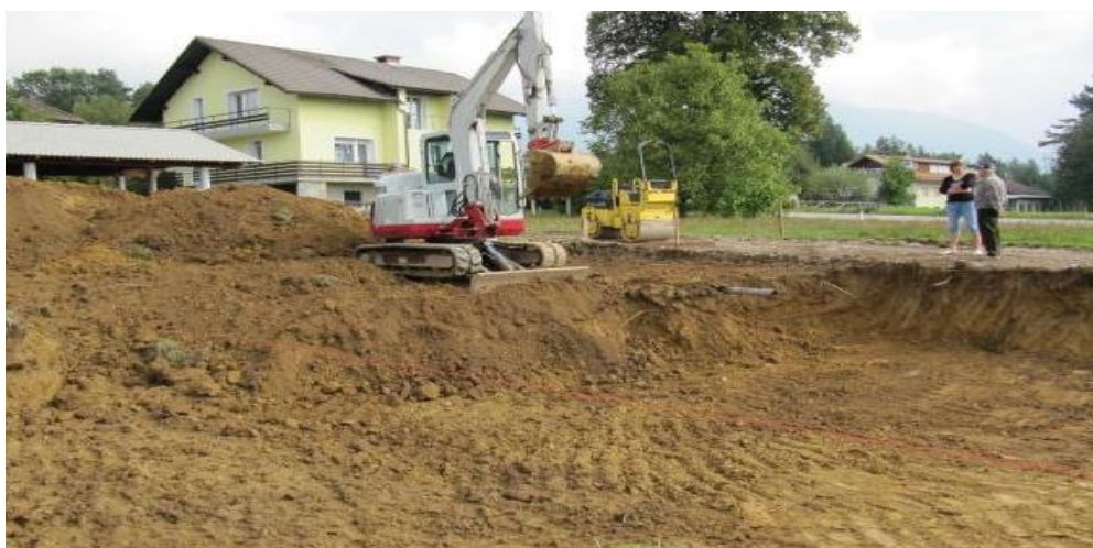
Slika 7: Ilovica, dobljena ob izkopu gradbene jame [26]
