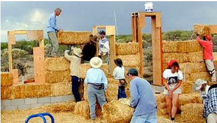
Slika 2: Gradnja hiše iz slamnatih bal [11]
