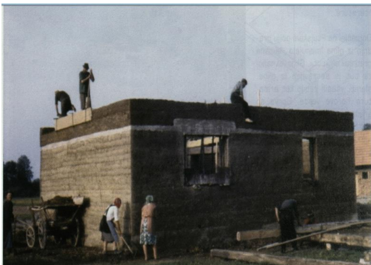
Slika 11: Gradnja butane hiše na Ptujskem polju (Foto: D.Moškon) [36]
