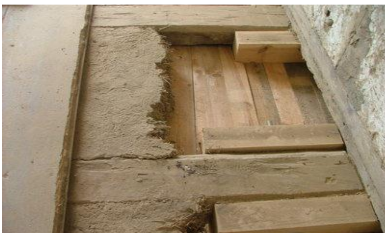
Slika 12: Lesena stropna konstrukcija z vmesnim ilovnatim polnilom [37]
