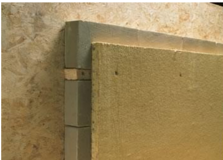
Slika 21: Obloga lesene stene s surovimi ilovnatimi opekami in ilovnato ploščo [52]
