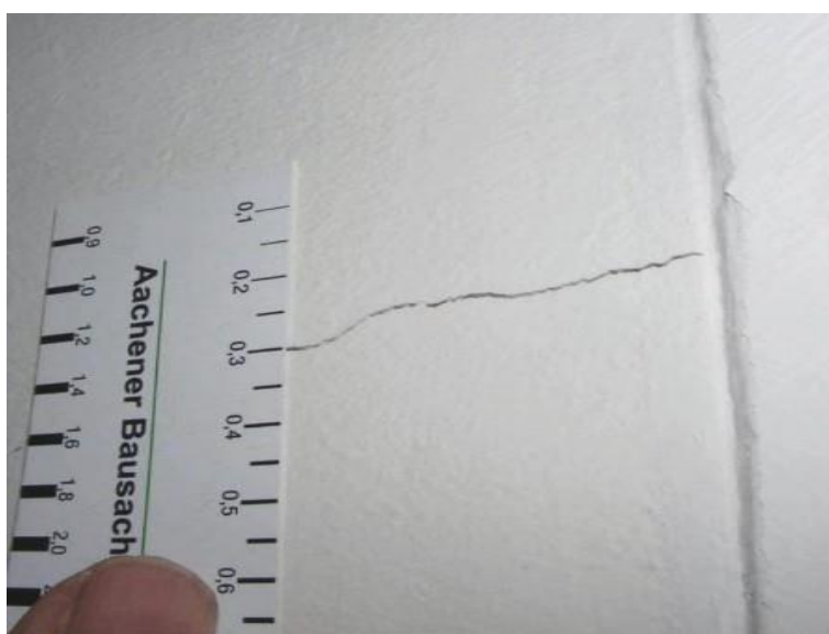
Slika 8: Prikaz razpokanega ometa [32]
