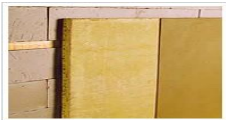
Slika 19: Primer vgradnje ilovnate suhomontažne plošče [51]
