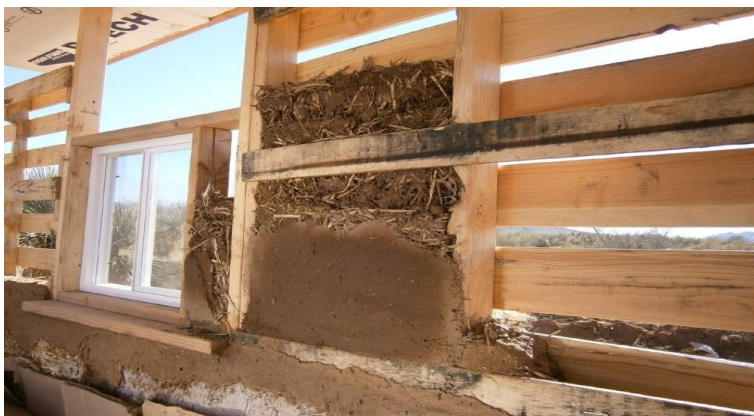
Slika 15: Stena, zgrajena iz ilovice, pomešane s slamo [40]
