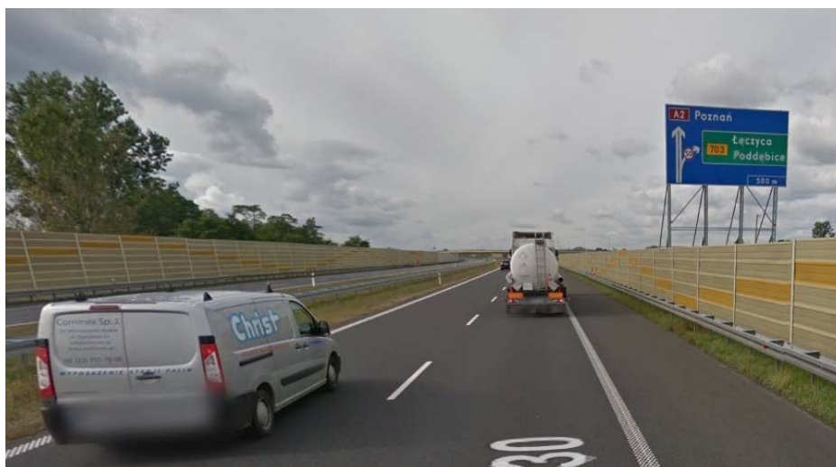
Slika 9: Viŝja konstrukcija predkriŝiŝĉne table za izvoz, Poljska (vir: Google StreetView)
