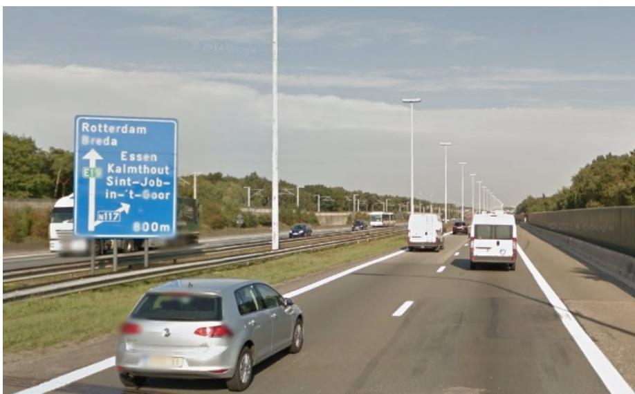
Slika 8: Postavitev predkriŝiŝĉne table za izvoz na levi strani cestiŝĉa, Belgija (vir: Google StreetView)
