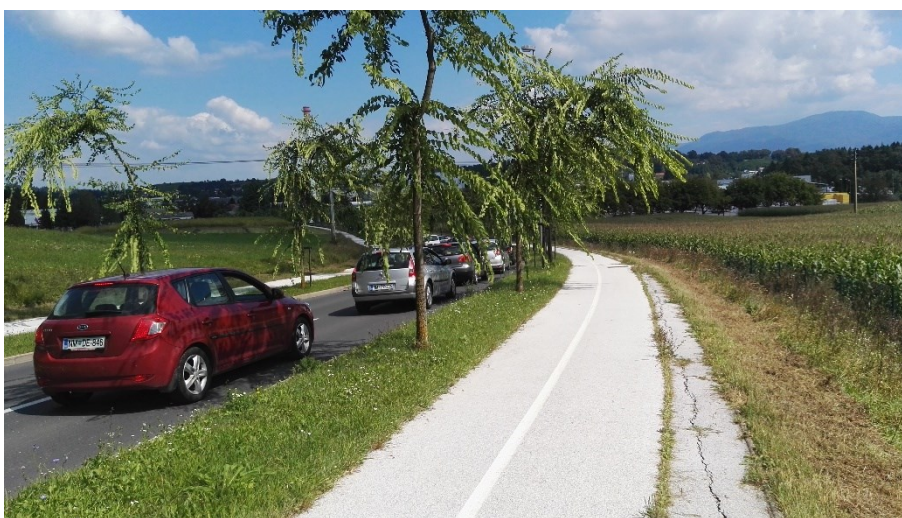
Slika 14: Posedki in razpoke vzdolž hodnika za pešce
