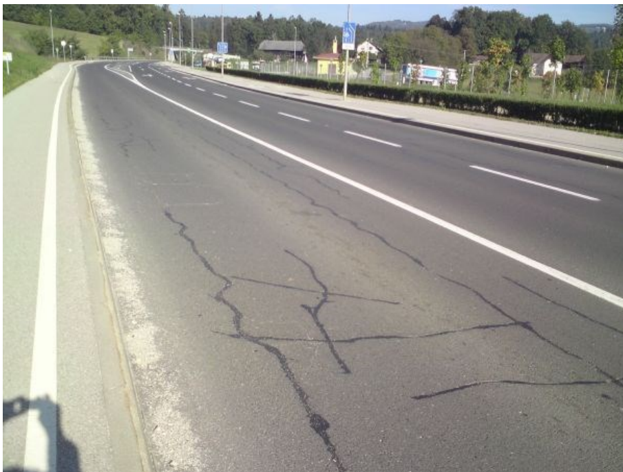
Slika 33: Vidne razpoke na Andrijaničevi cesti, smer avtocesta
