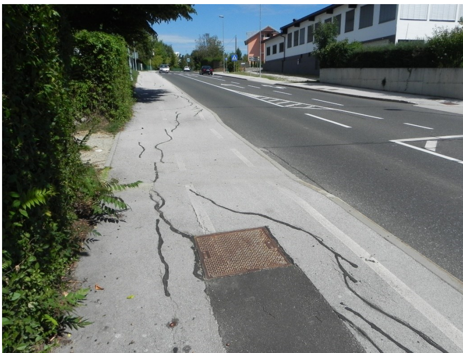
Slika 41: Sanacija razpok na obnovljeni Belokranjski cesti
