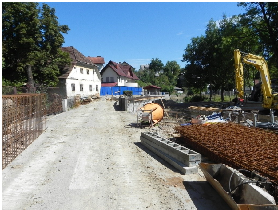
Slika 42: Nova izgradnja mostu na Smrečnikovi ulici zaradi spomeniško zaščitenega objekta
