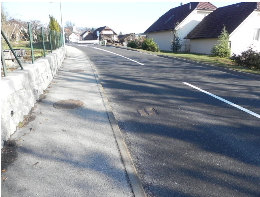
Slika 19: Vtočne rešetke, zgrajene v liniji kolesnice
