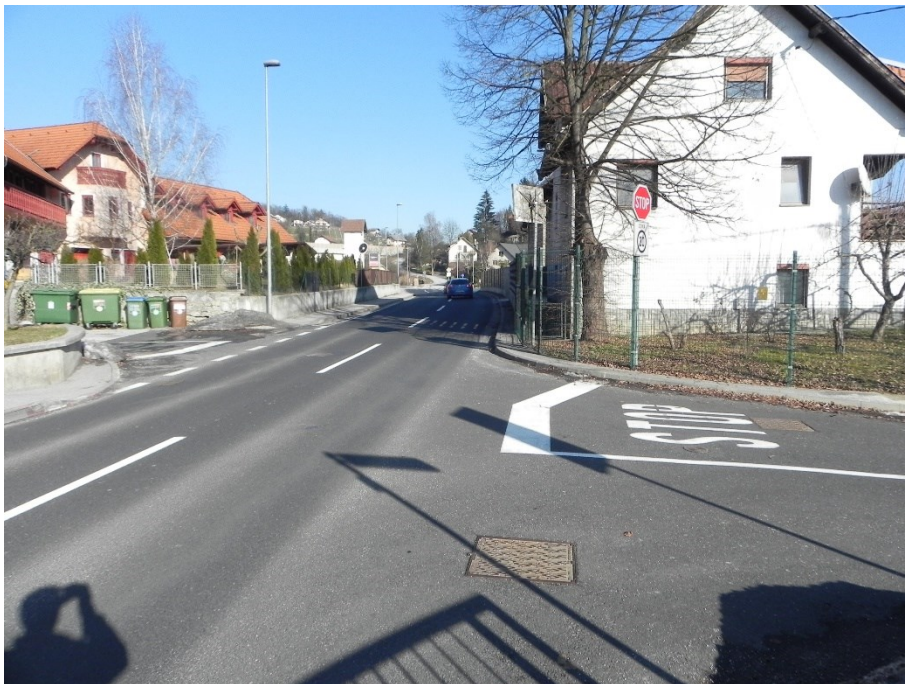
Slika 23: Priključevanje Mlinarske poti na Šmarješko cesto, nezadostna preglednost
