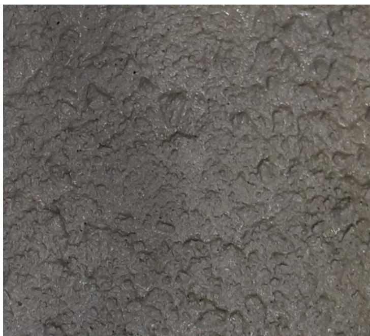
Slika 11: Prikaz sveže betonske mešanice.
