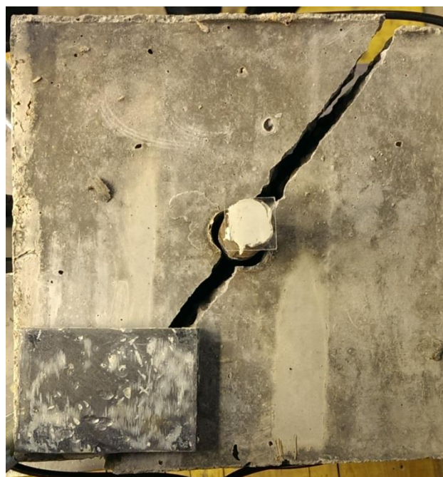
Slika 19: Porušitev preizkušanca NC-1630-3_3.
